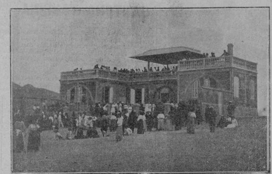
SANTONA.—Fachada principal del suntuoso balneario de la playa de Berria. (Fot. González.)
