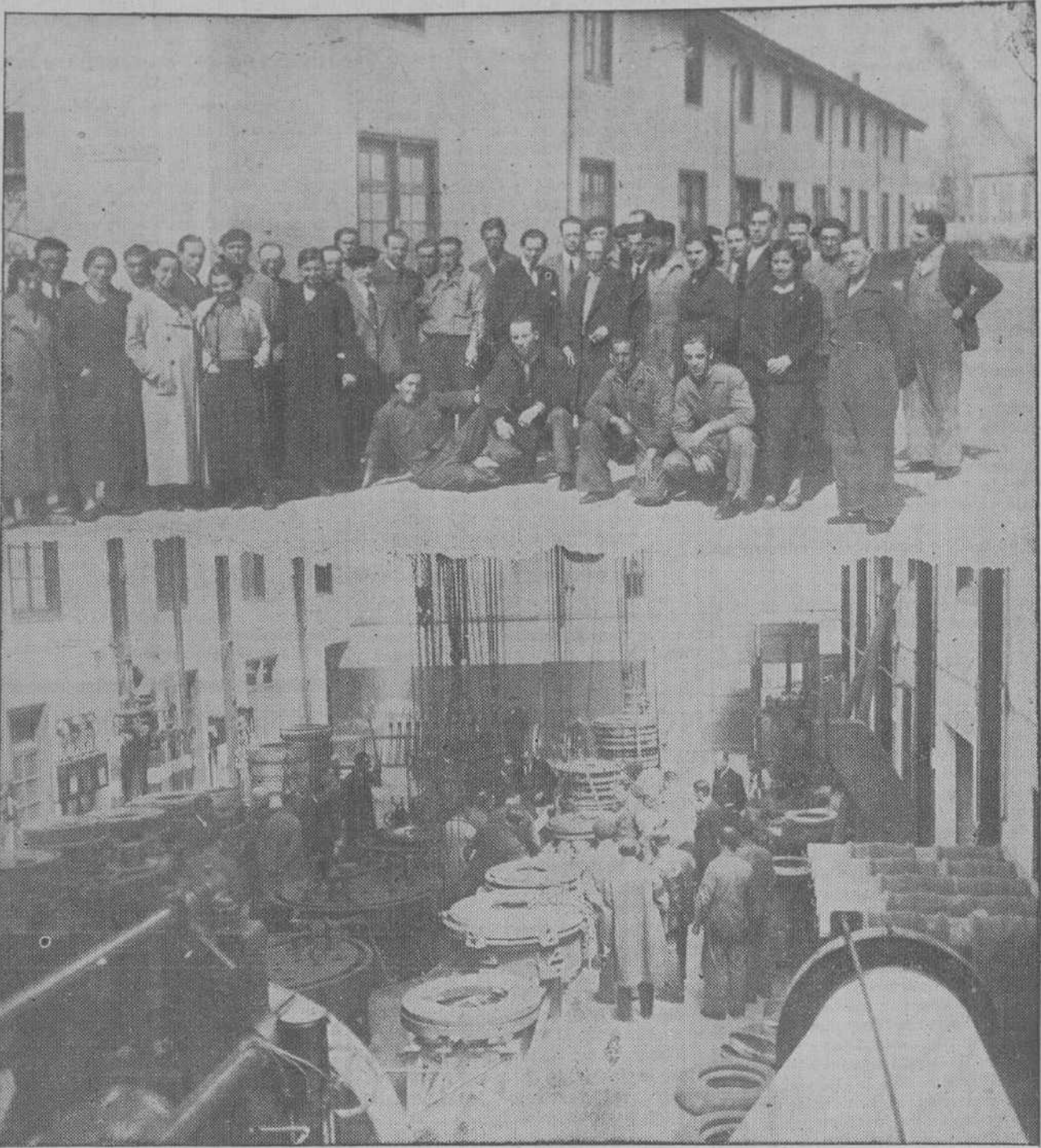
INDUSTRIAS DE LA RETAGUARDIA.—La Dirección general de Industria, en su labor de velar desde la retaguardia por la prosperidad de las industrias, ha logrado llevar adelante su propósito de poner de nuevo en marcha la importante fábrica de cubiertas y cámaras «Continental».—En el grupo, el director general de Industria, don Valeriano González Puertas; el de Trabajo, don Antonio Ramos; el alcalde de Torrelavega, técnicos y obreros, momentos después de reanudar los labores en aquella factoría.—(Fot. Alejandro).
