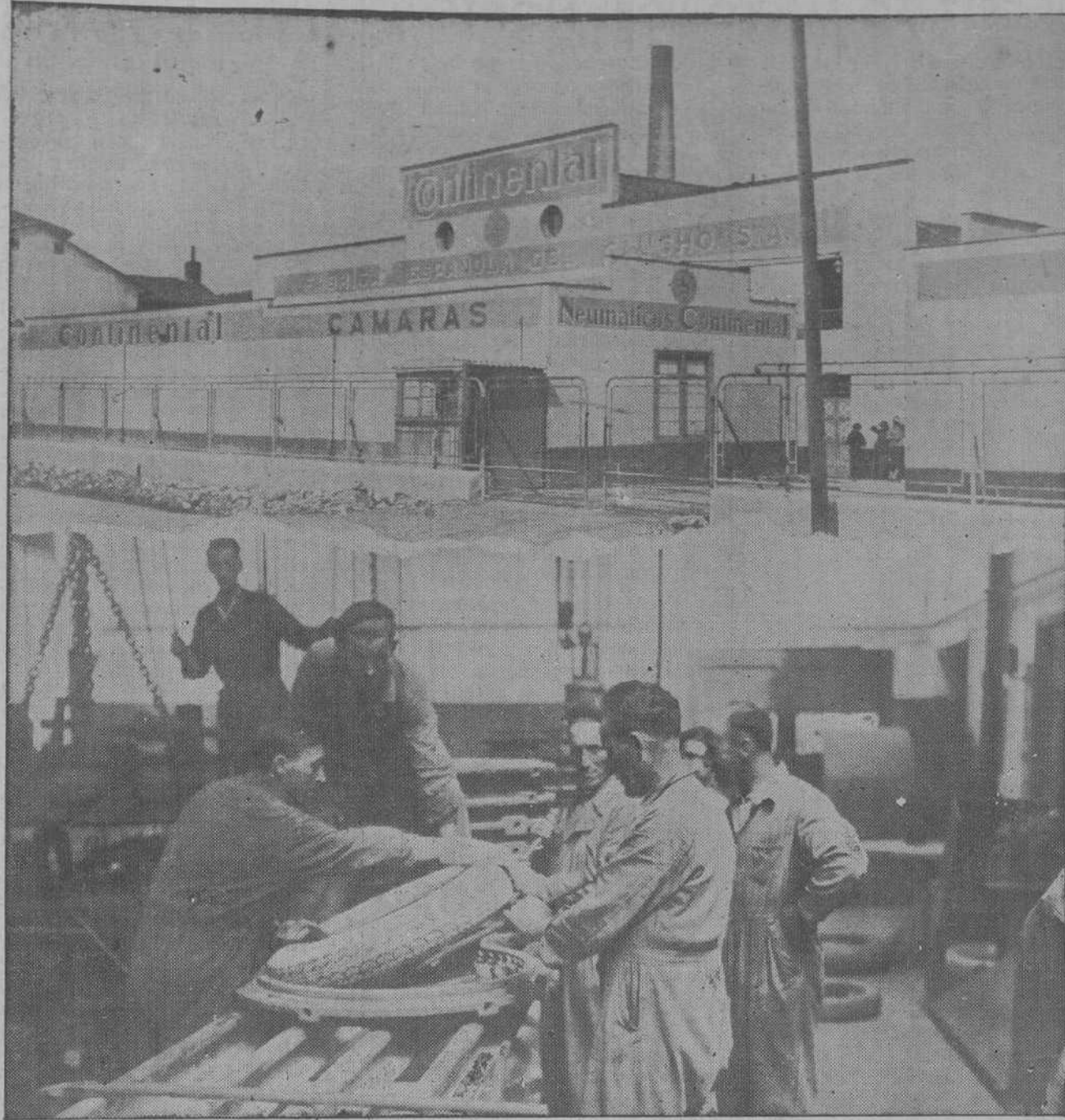
OTRA INDUSTRIA EN MARCHA.—Ayer tuvo lugar en Torrelavega la reanudación de los trabajos en la fábrica de cubiertas y cámaras «Continental».—Las fotos recogen un aspecto exterior de la fábrica y del momento en que los obreros sacan la primera cubierta terminada.—(Foto Alejandro.)
