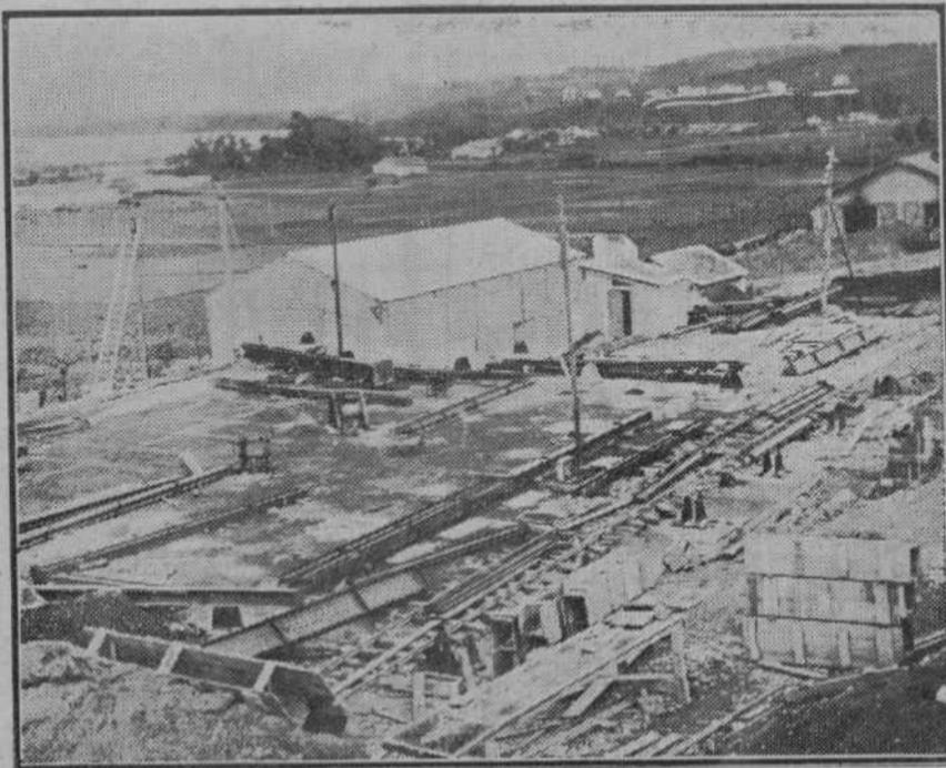
LA FABRICA DE HINOJEDO EN CONSTRUCCION.—Planta sobre la que se colocará la importante maquinaria de calcinación de blenda. (Foto MONTESINOS).
