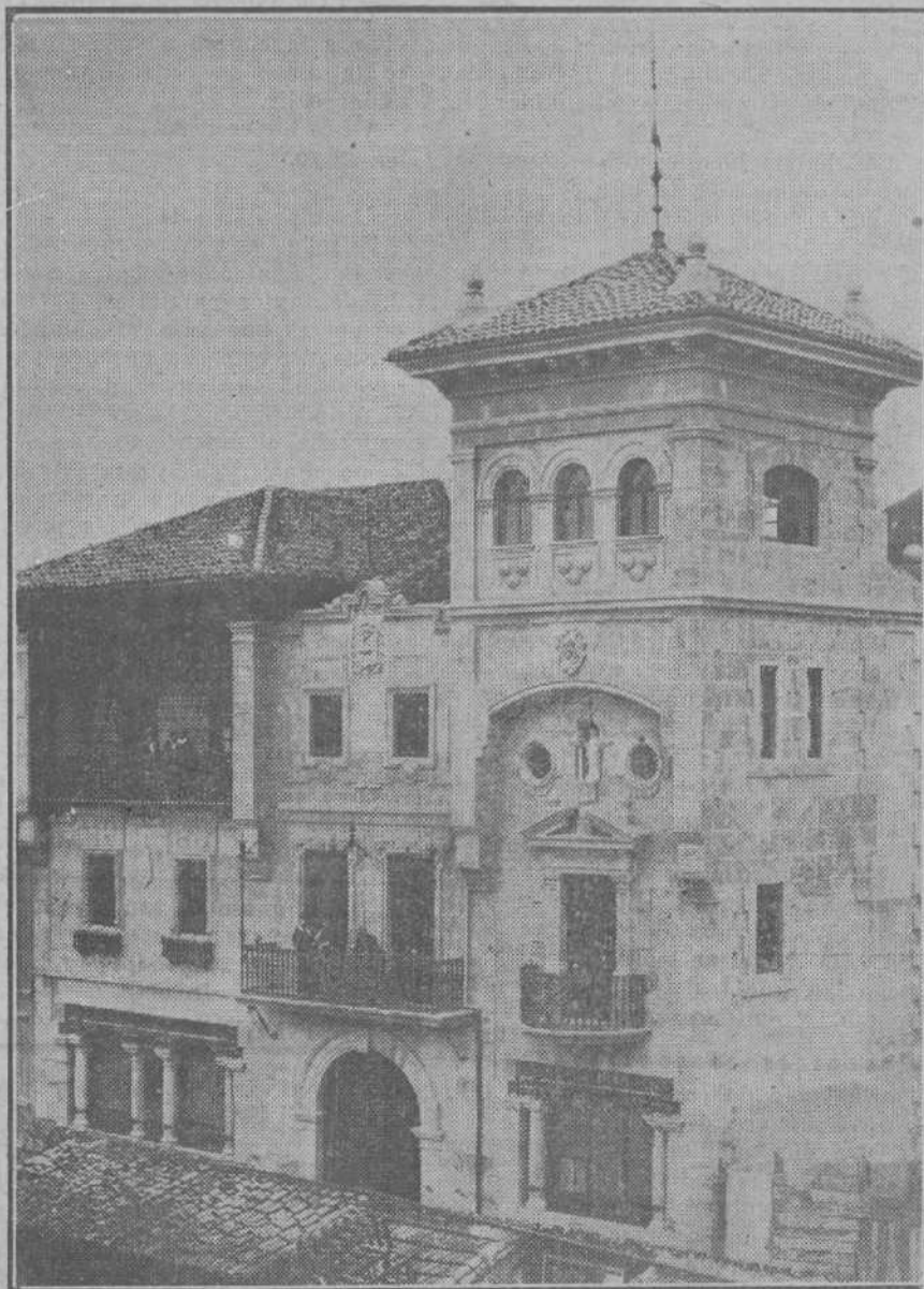
La magnífica casa de don Pedro Castañeda, en Santoña, que el domingo fué destruída totalmente por un incendio. (Foto LEONCIO).
