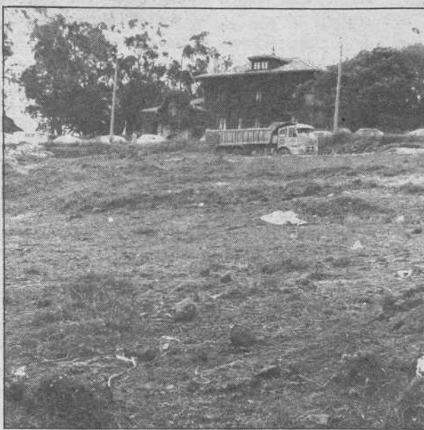
Aspecto de la finca (al fondo, el Parque Altamira), en la que se construirán trescientas noventa y dos viviendas. (Foto: M. Bustamante)
