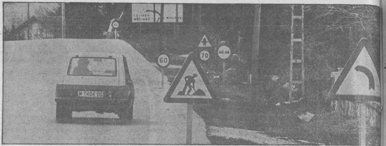
BOSQUE DE SENALES. —Un defecto tan frecuente como la falta de señalización es el exceso de señales en corto espacio, algo abrumante para el conductor, ya que ante tantas llamadas de atención siempre se salta alguna y a la hora de la verdad no sabe si tiene o no preferencia, puede adelantar o lleva la dirección correcta. La exageración llega a unir literalmente limitaciones de velocidad distintas y, en cualquier caso, un conductor responsable debe recordar el viejo refrán de «casa con mil puertas...», bajando la velocidad al máximo para evitar más holgadamente cualquier imprevisto.
