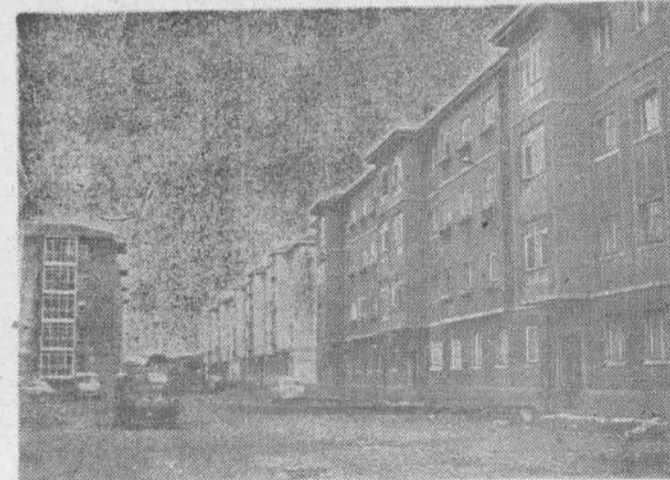
Pavimentación de la Avenida de la Naval, construida por «Tamisa». (Foto A. GOMEZ.)
