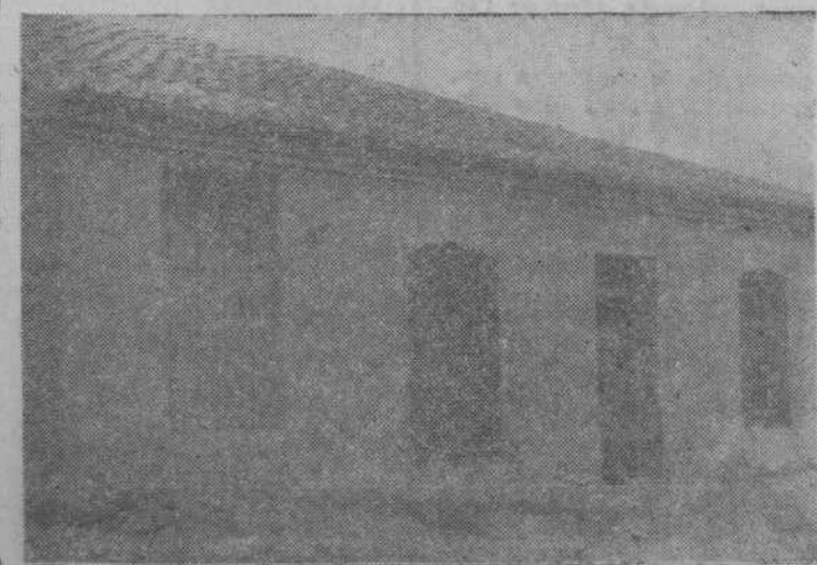
Fachada de la casa que habitaban Domingo Laso y su esposa, Ramona Laso, con Lino Herrero. (Foto Guzmán Gombau.)
