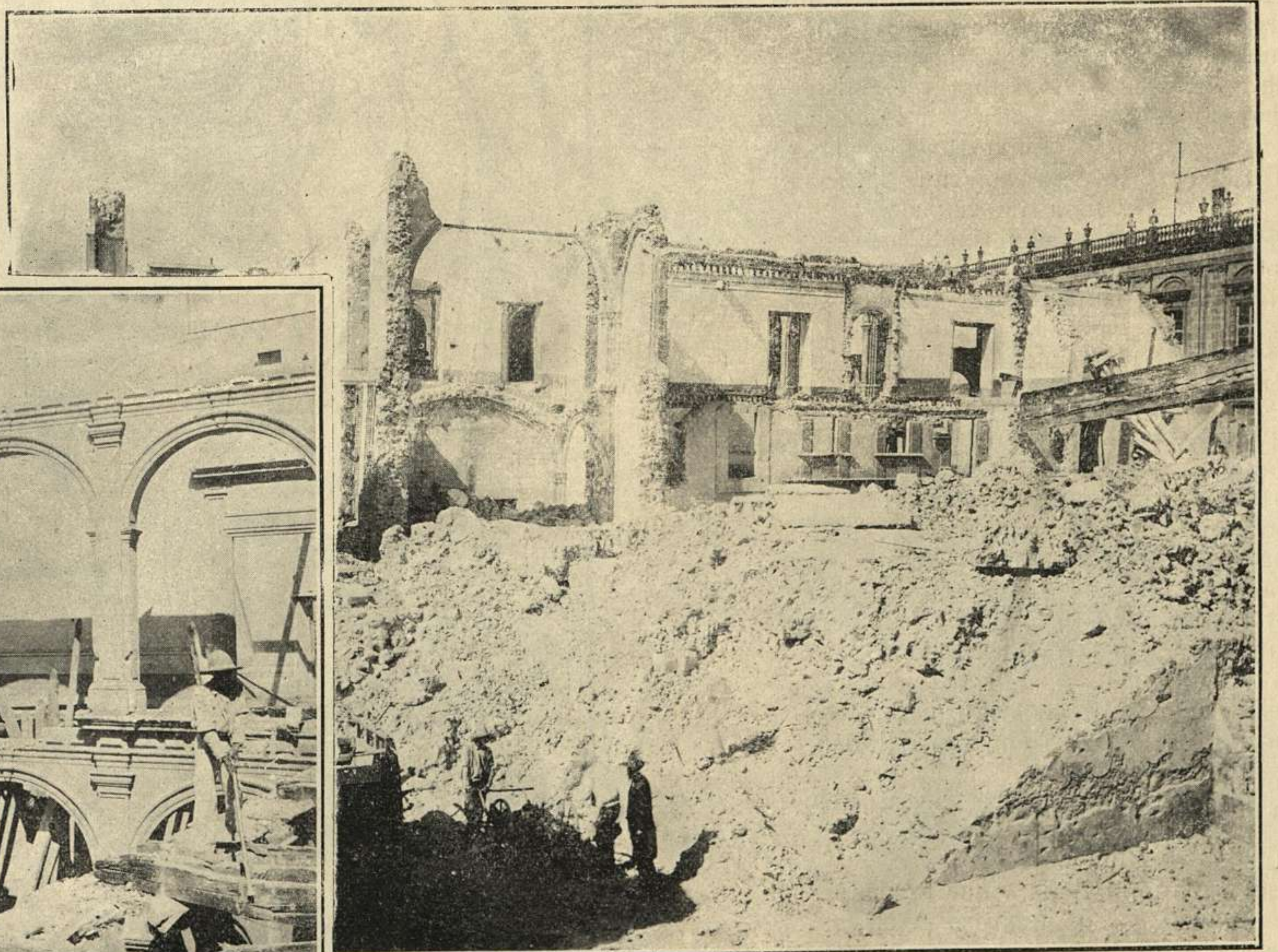
La demolición más avanzada en el lado poniente
