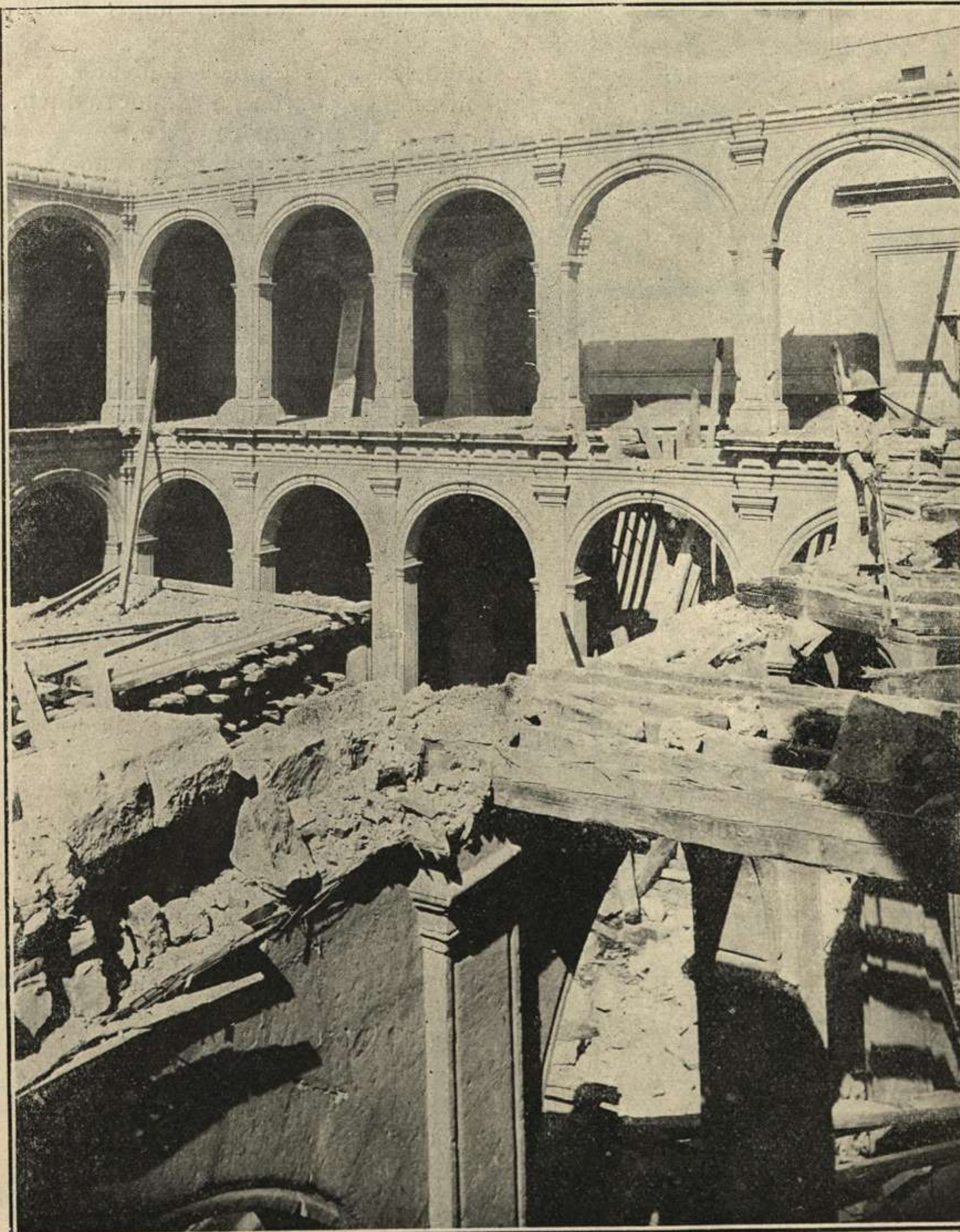
Patio principal en demolición.
