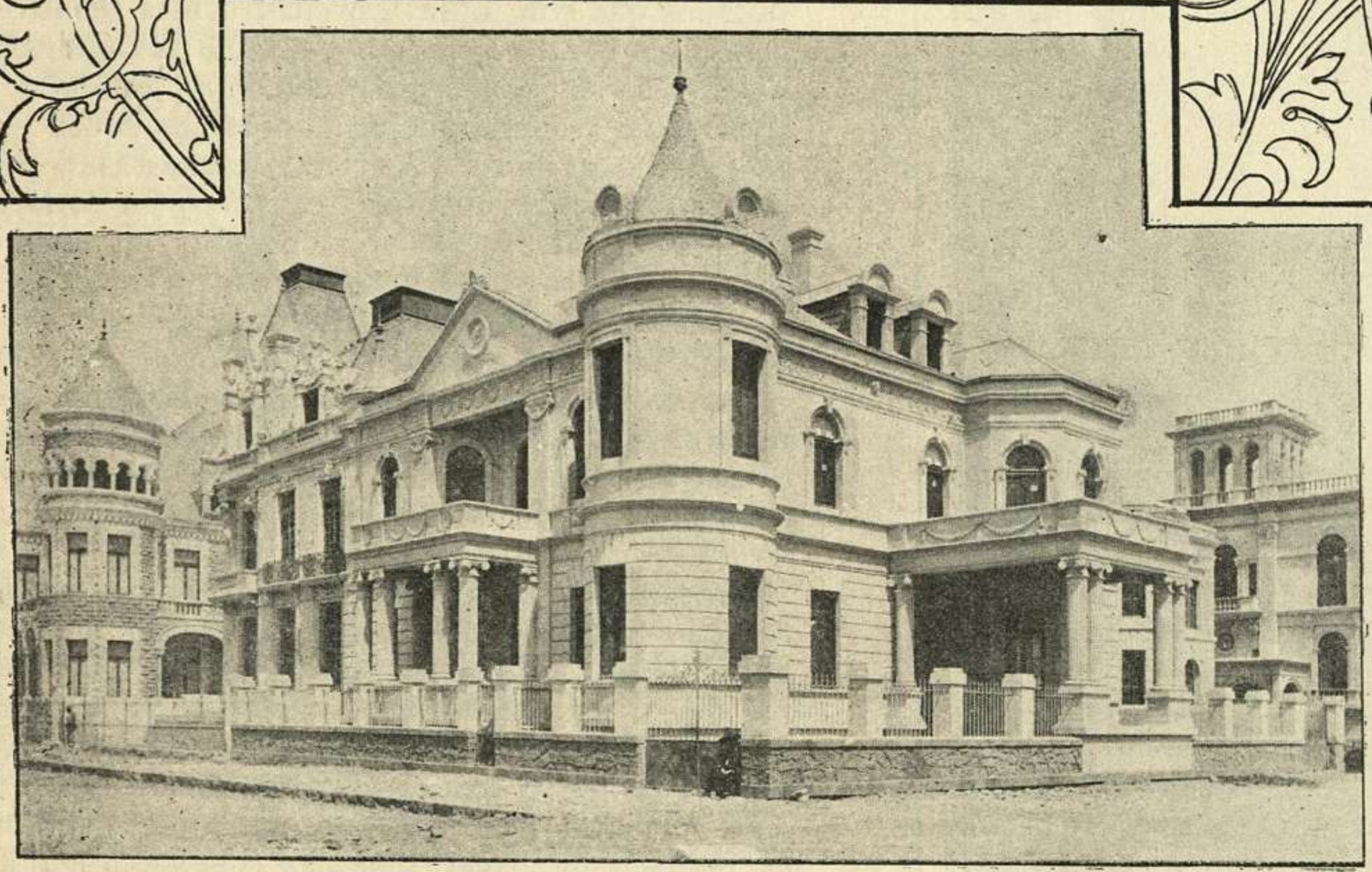
CASA DEL SR H. MARQUARD.
