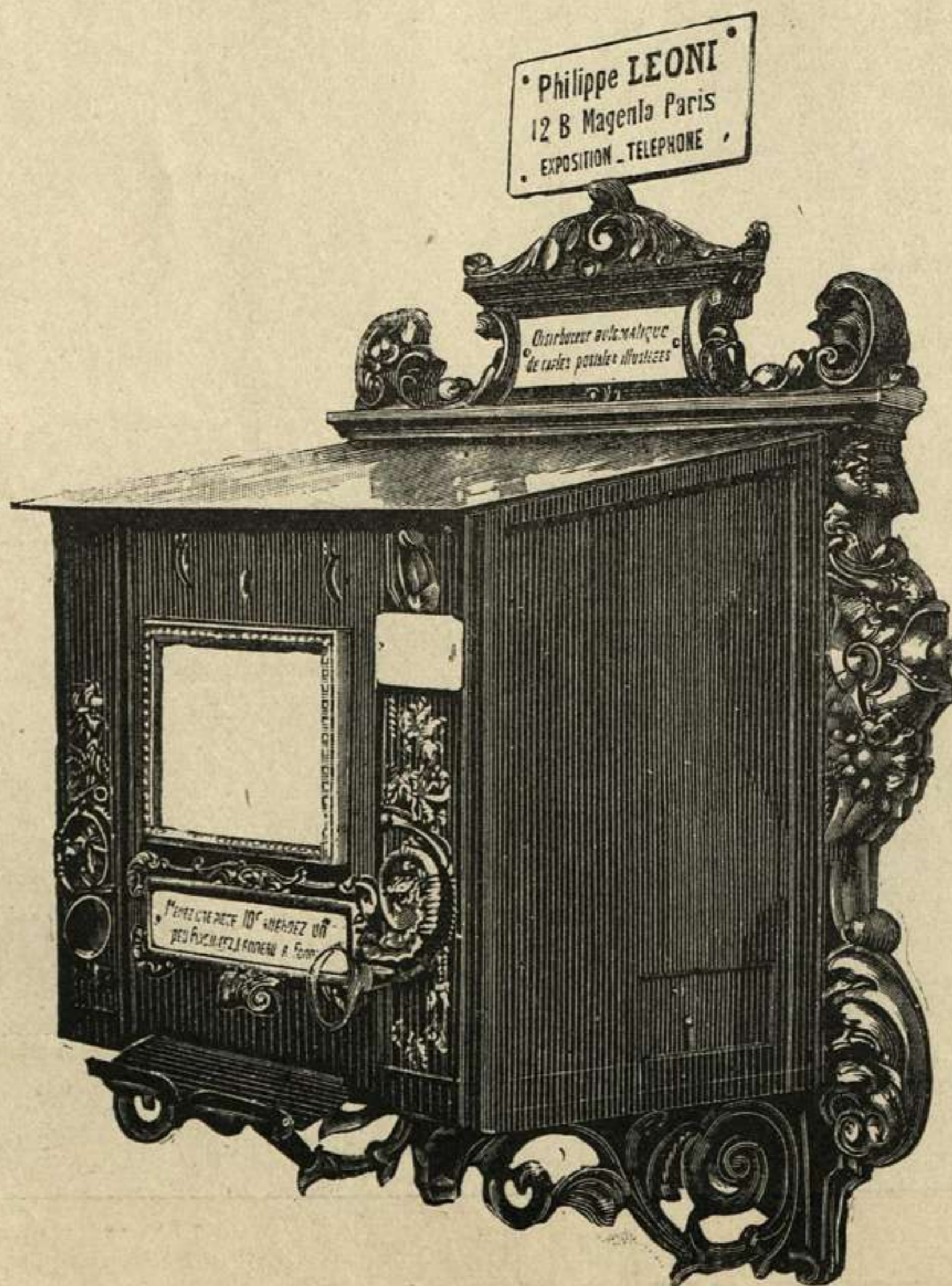
Teléfono automático. Funciona durante cierto tiempo introduciendo una moneda en la abertura correspondiente.
