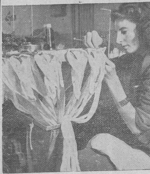
Una obrera de una fábrica británica de las famosas medias de Nylon, trabajando con una máquina para unir el talón con el piso (Foto Calpe).
