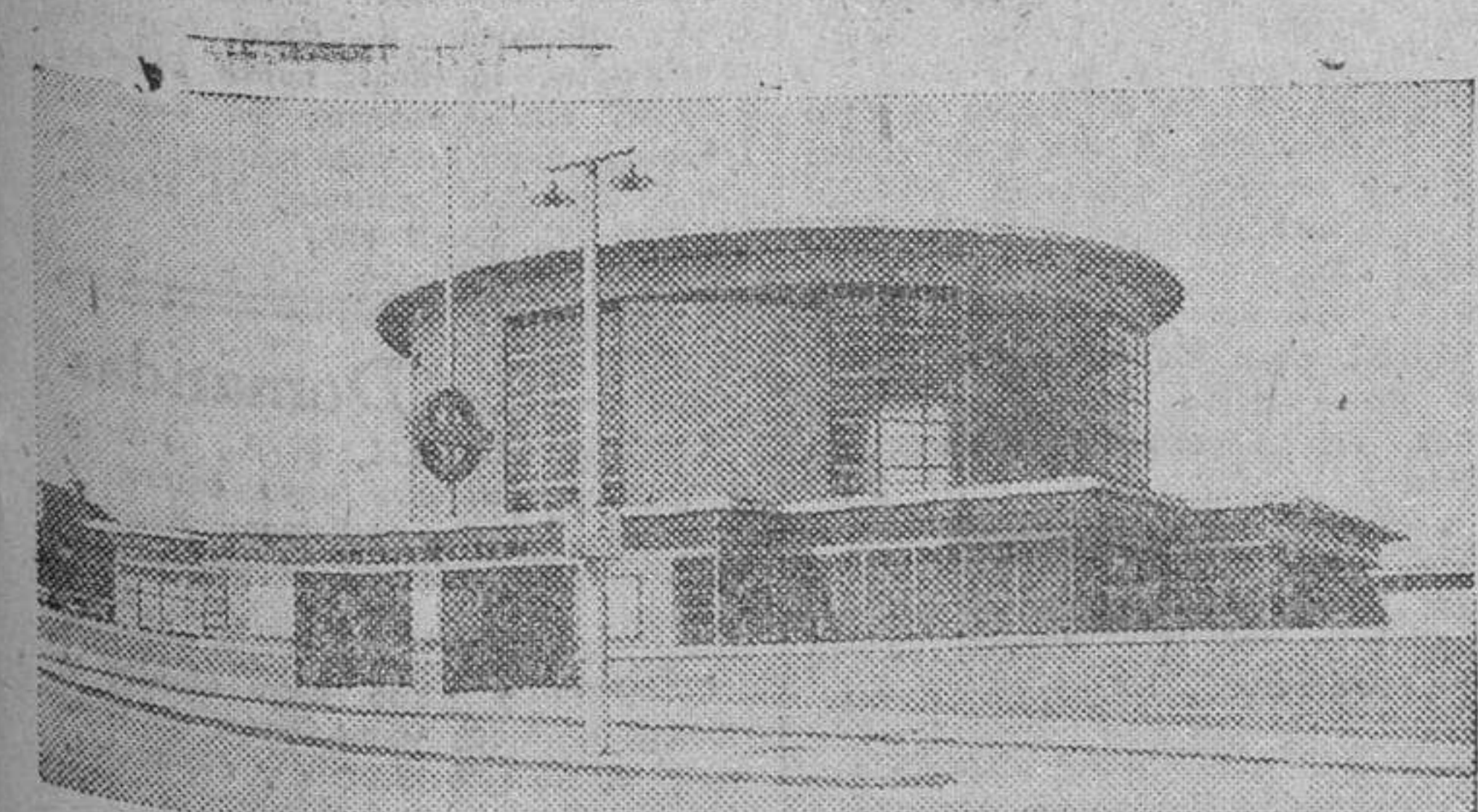
En esta fotografía podemos ver una de las nuevas estaciones del metro londinense, construidas según los nuevos planes para la reedificación de Londres (Foto Calpe).
