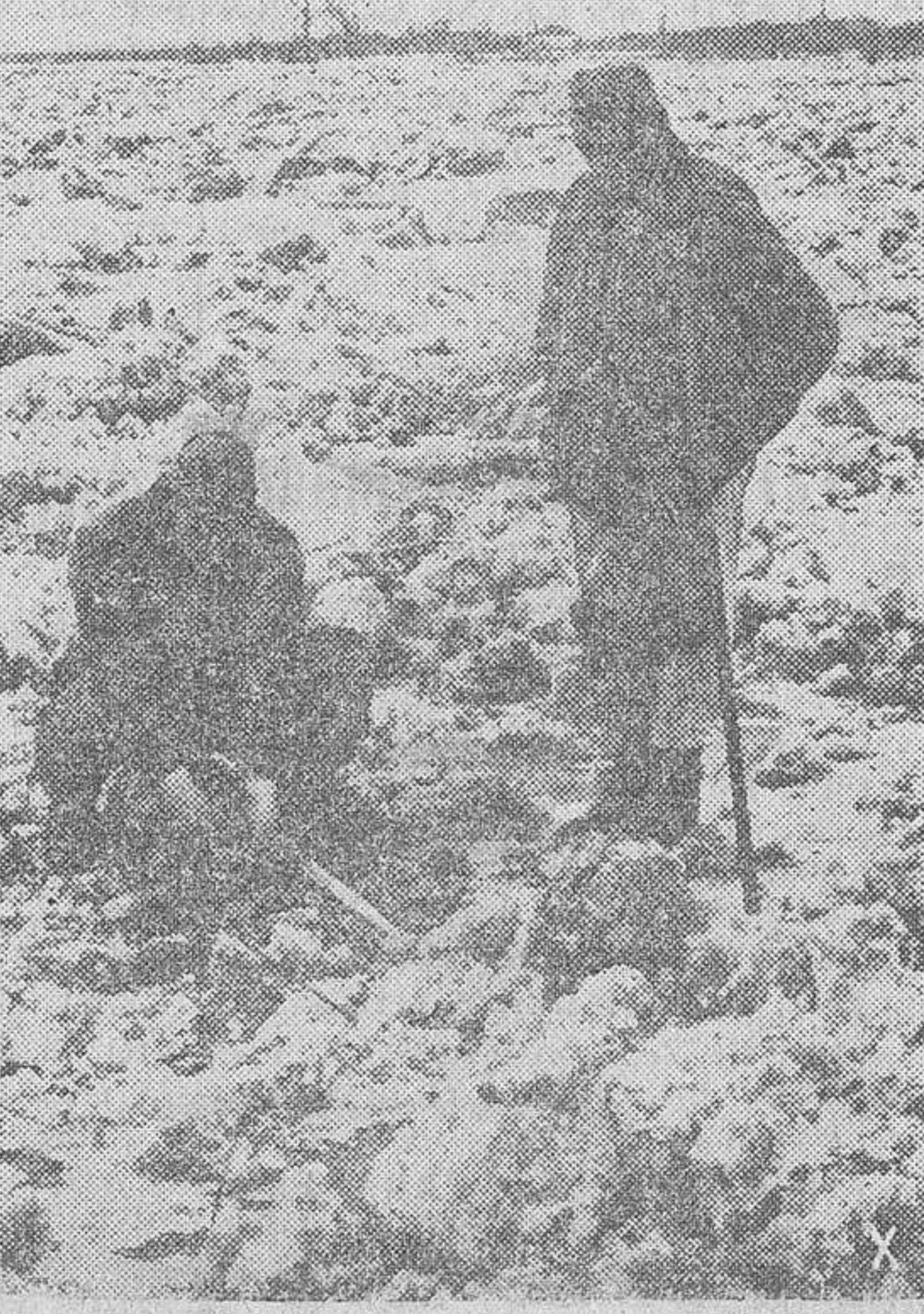
Pontoneros alemanes colocando una carga de dinamita en los hielos del Donez, para restablecer la navegación en el río.
