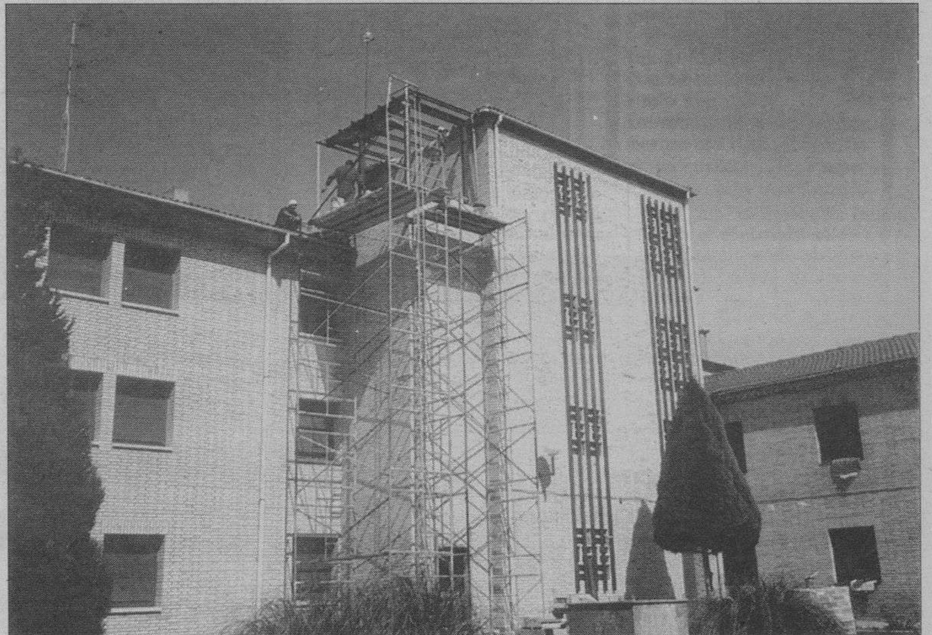
LA RESIDENCIA DE ANCIANOS DE MEDINA CONTARA CON UN SEGUNDO ASCENSOR.- La Residencia de Ancianos de Medina de Pomar ha comenzado las obras para realizar un segundo ascensor, ya que la Junta de Patronos persigue una mayor calidad de vida de los residentes con mejores instalaciones y prestación de servicios.
