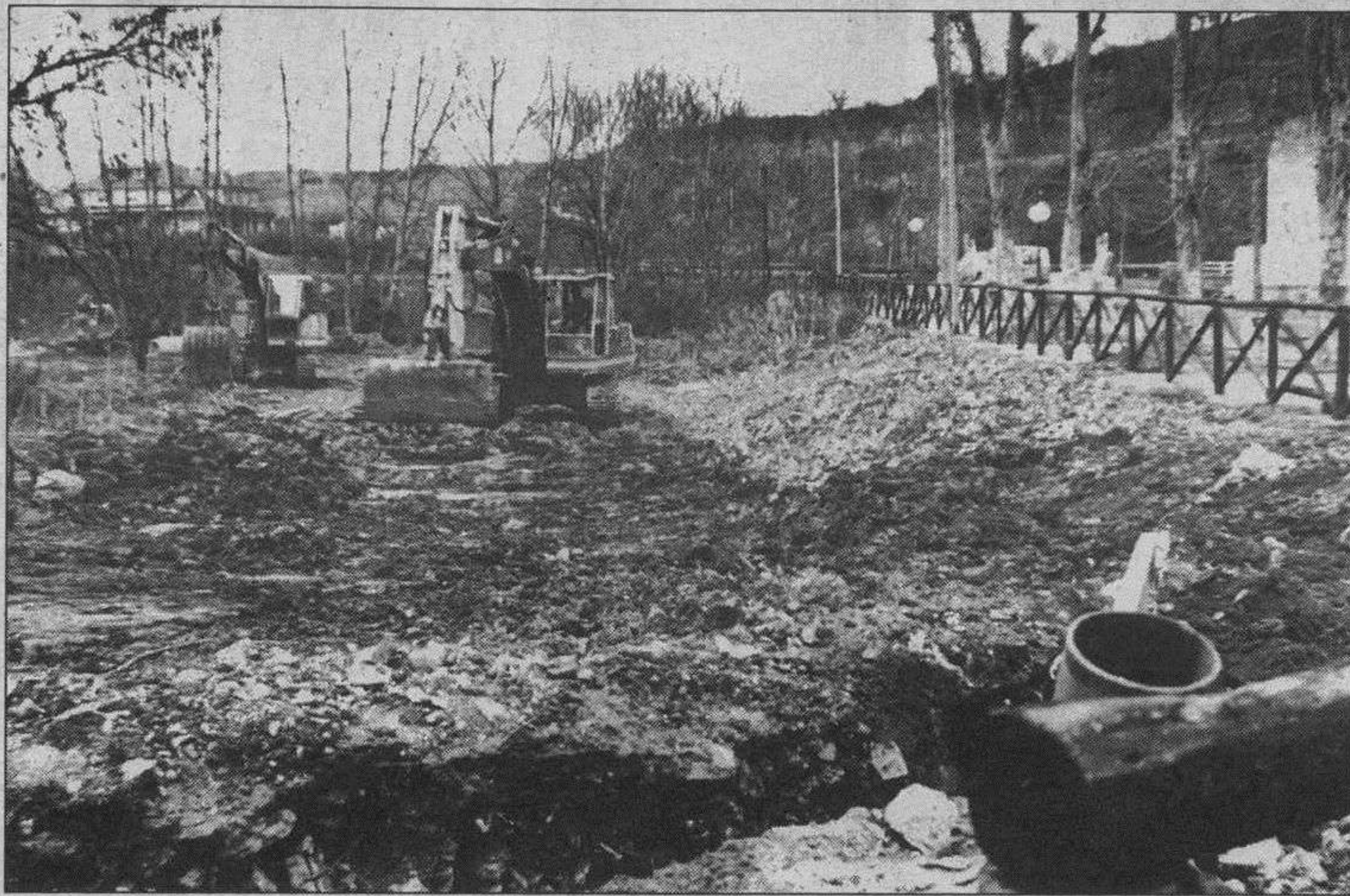
Los trabajos de conducción del gas al polígono industrial se encuentran muy avanzados.
