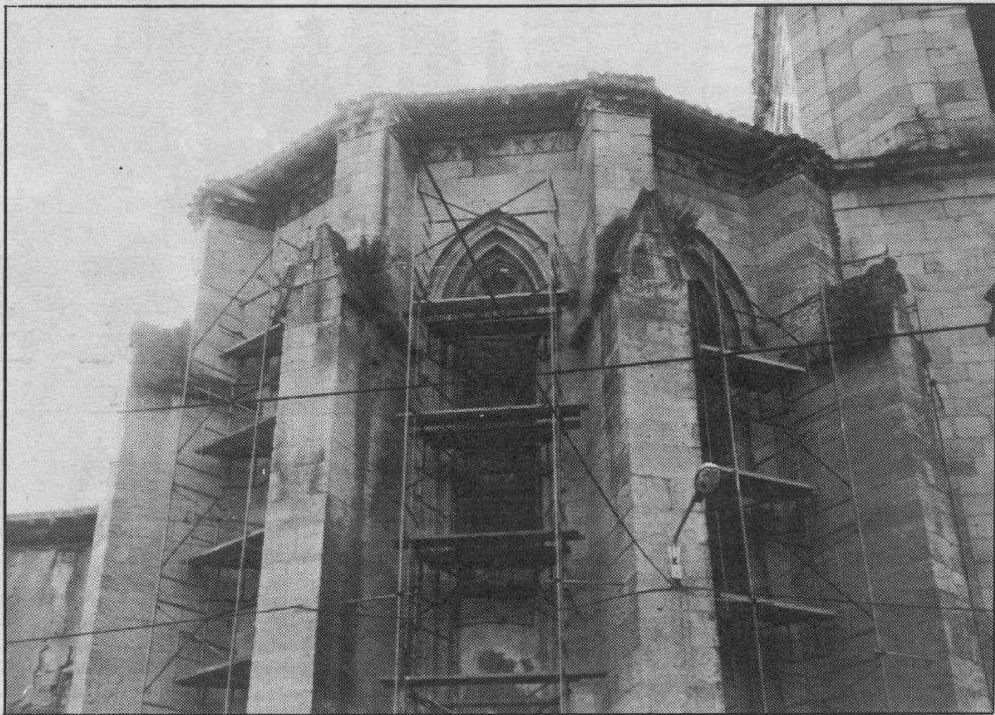
Las vidrieras deben desmontarse y trasladarse para asegurar su correcta restauración.
