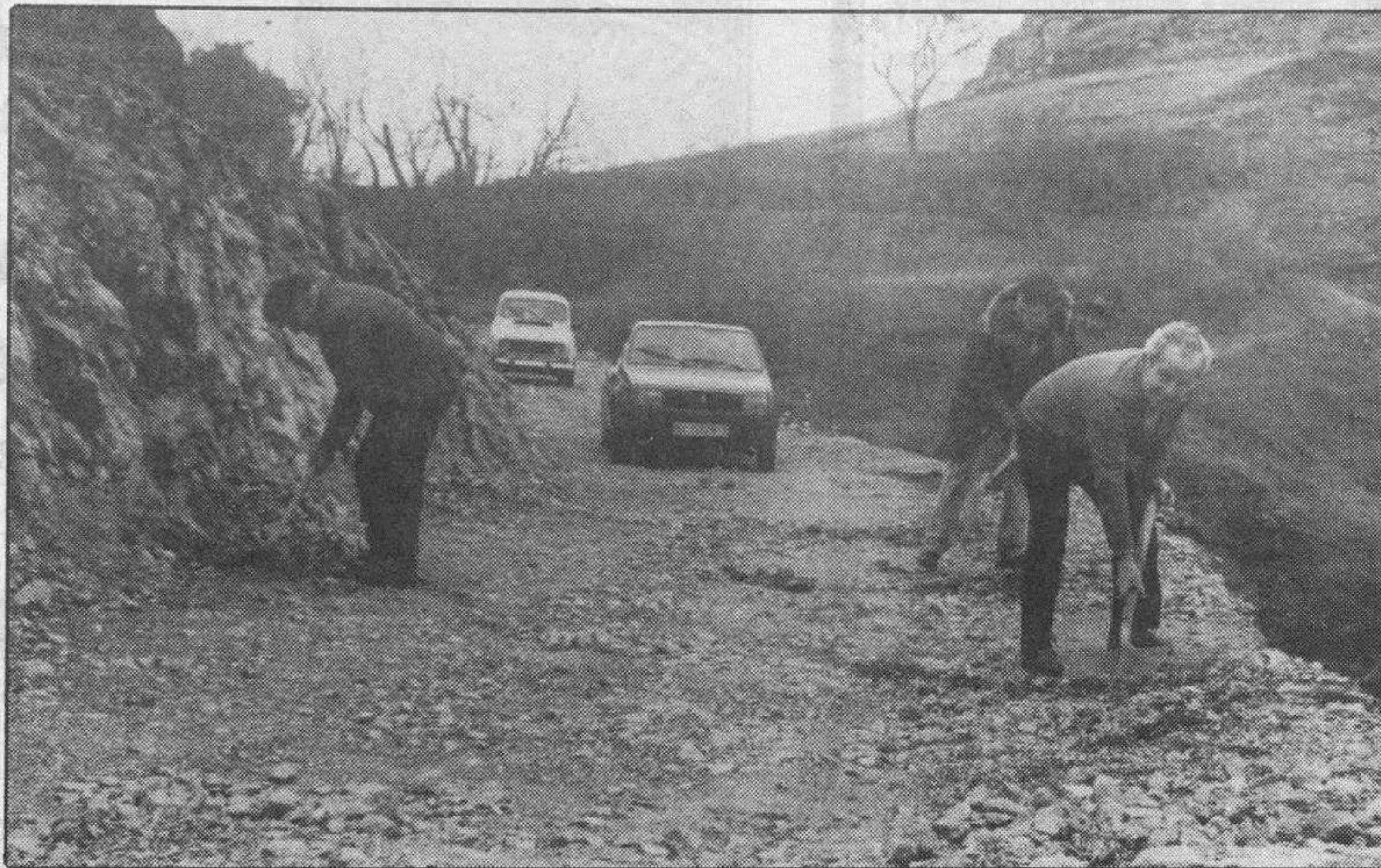
En las carreteras con pavimento en mal estado, los amortiguadores trabajan «a tope».
