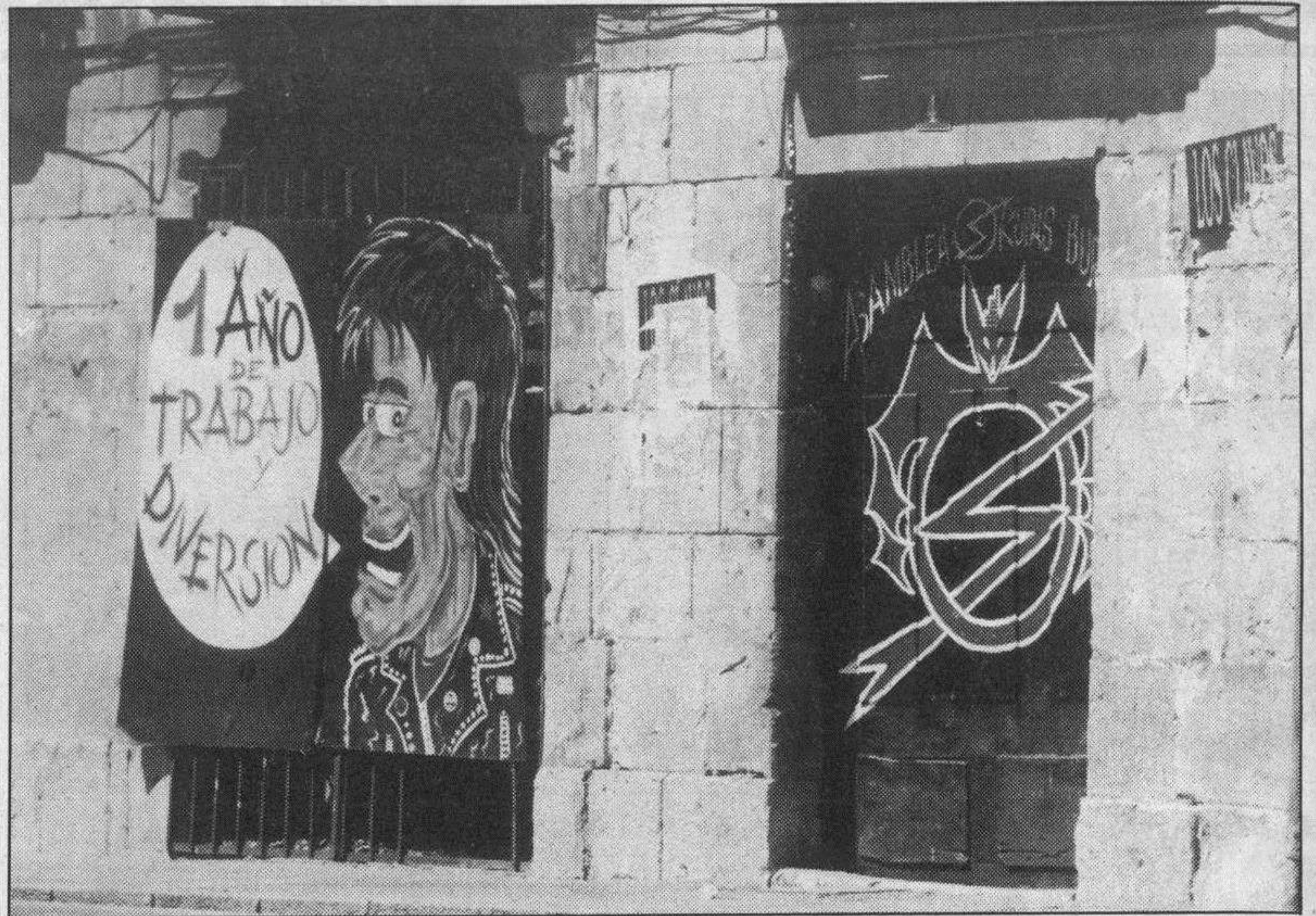
Los «okupas» aseguran que la estructura de la vivienda está en buen estado. (Foto: Luis L. Araico).
