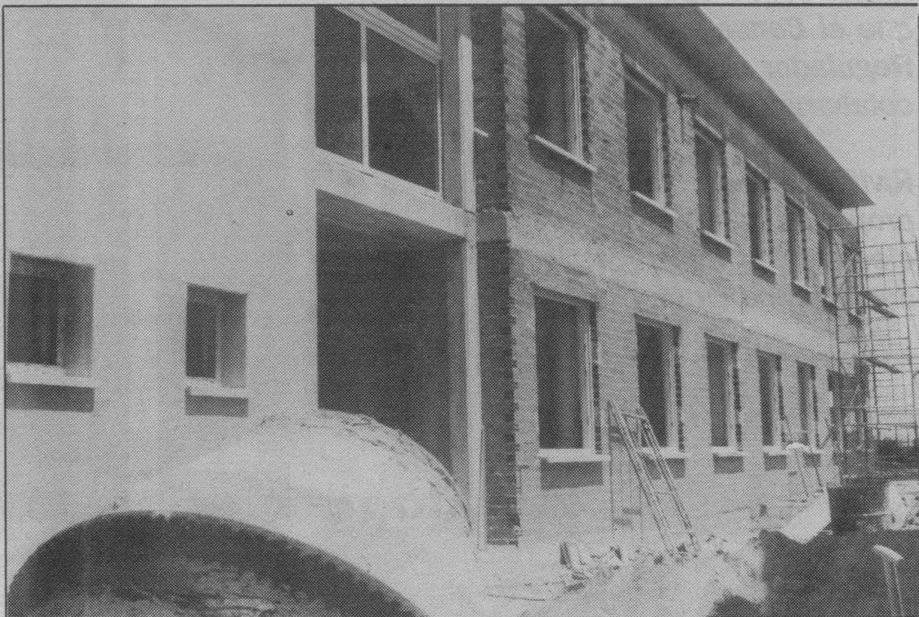
Las obras del edificio están prácticamente terminadas. (Foto: Truchuelo).
