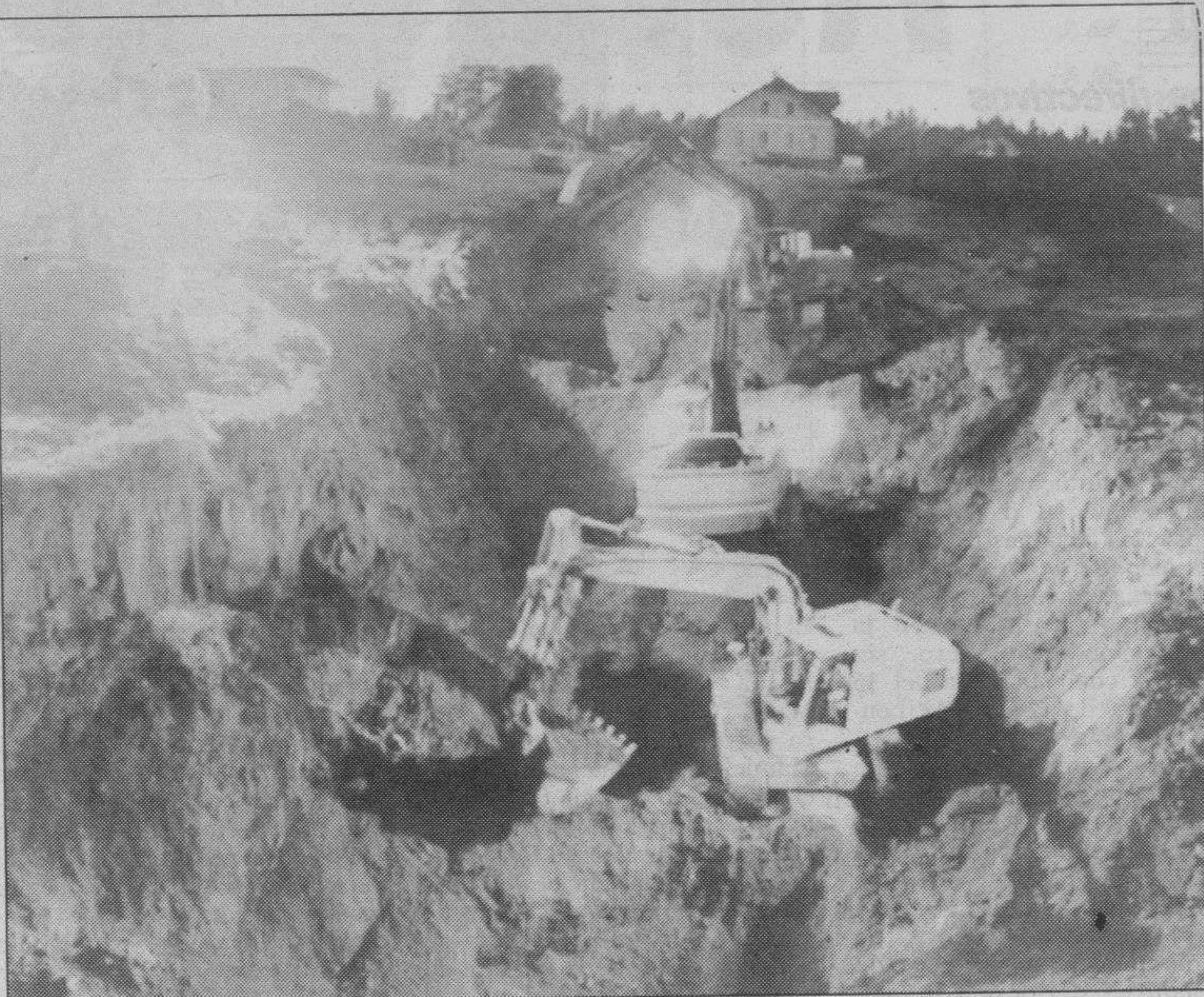
Maquinaria pesada trabaja activamente para rescatar a los cinco hombres. (Foto: Efe).
