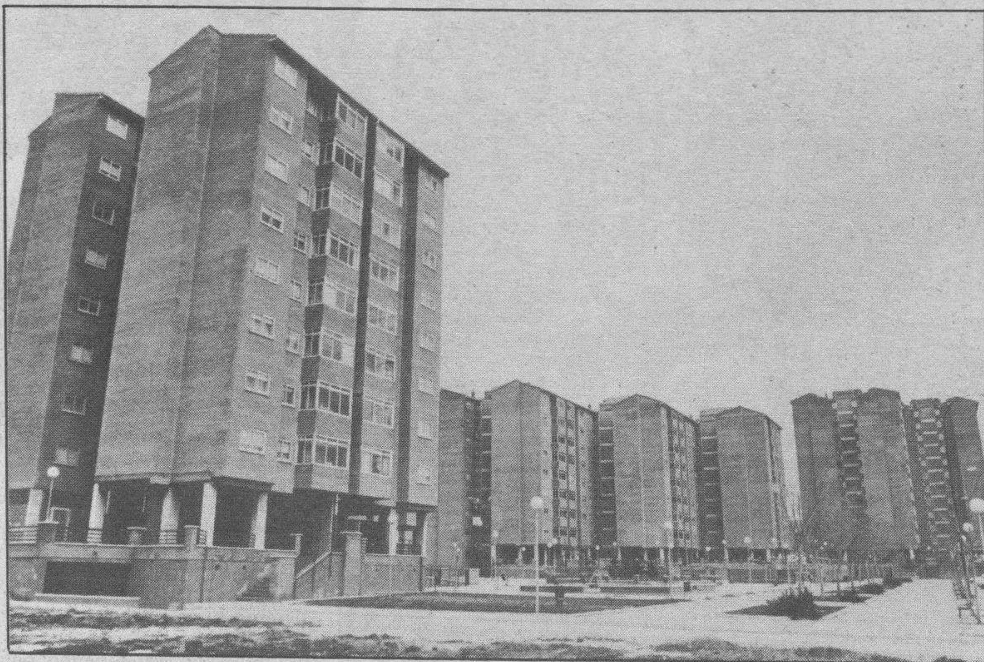
Las viviendas de protección oficial de esta zona sufren numerosos problemas. (Foto: A. Ayala).
