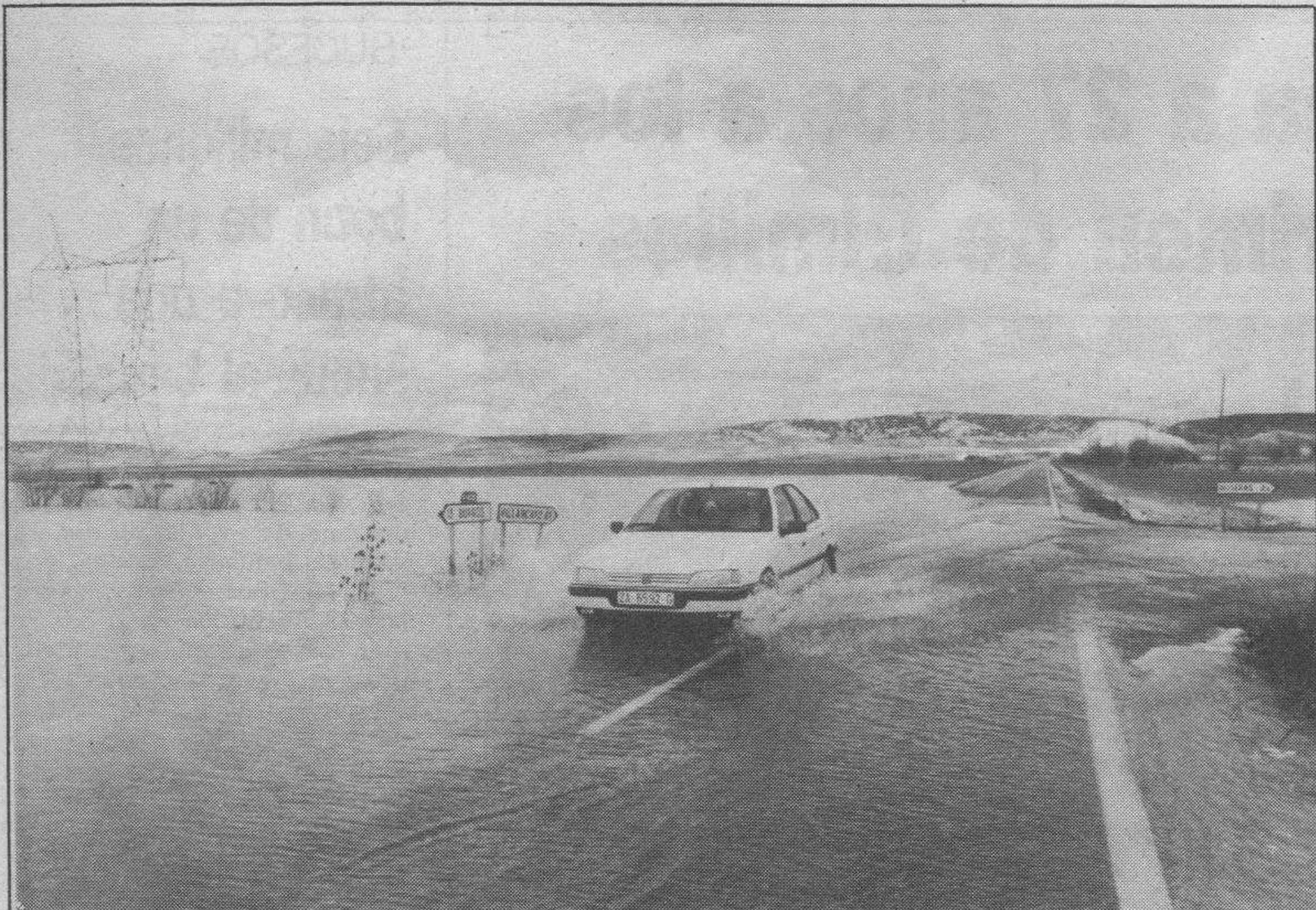
El Ubierna presentó dificultades en la BU-629, Burgos-El Crucero, cerca del cruce con Rioseras, aunque no fue necesario cortar el tráfico. (Foto: A. Rodrigo)
