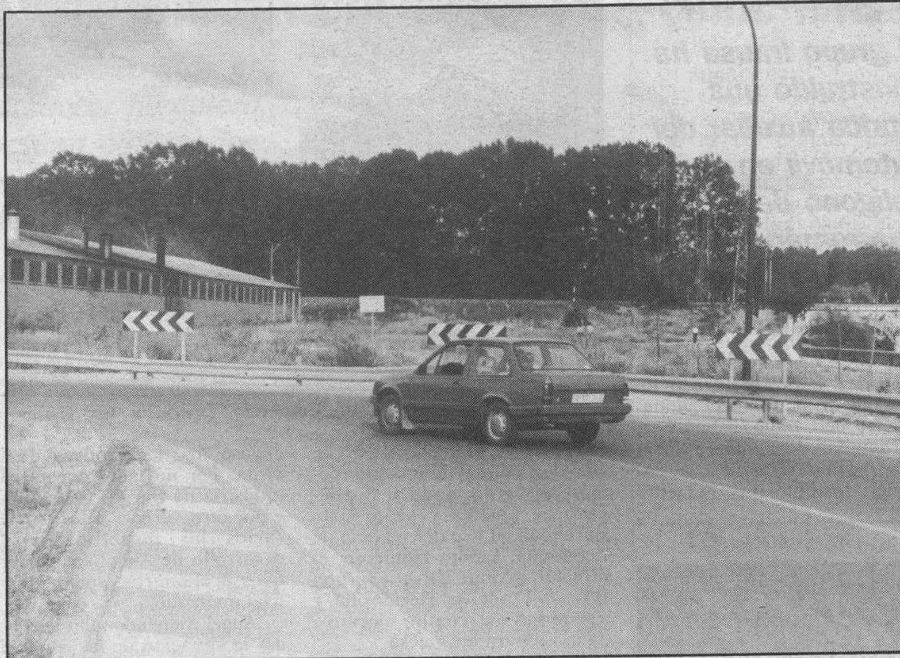
La nueva vía discurrirá paralela al ferrocarril en la zona de Capiscol. (Foto: Angel Ayala).
