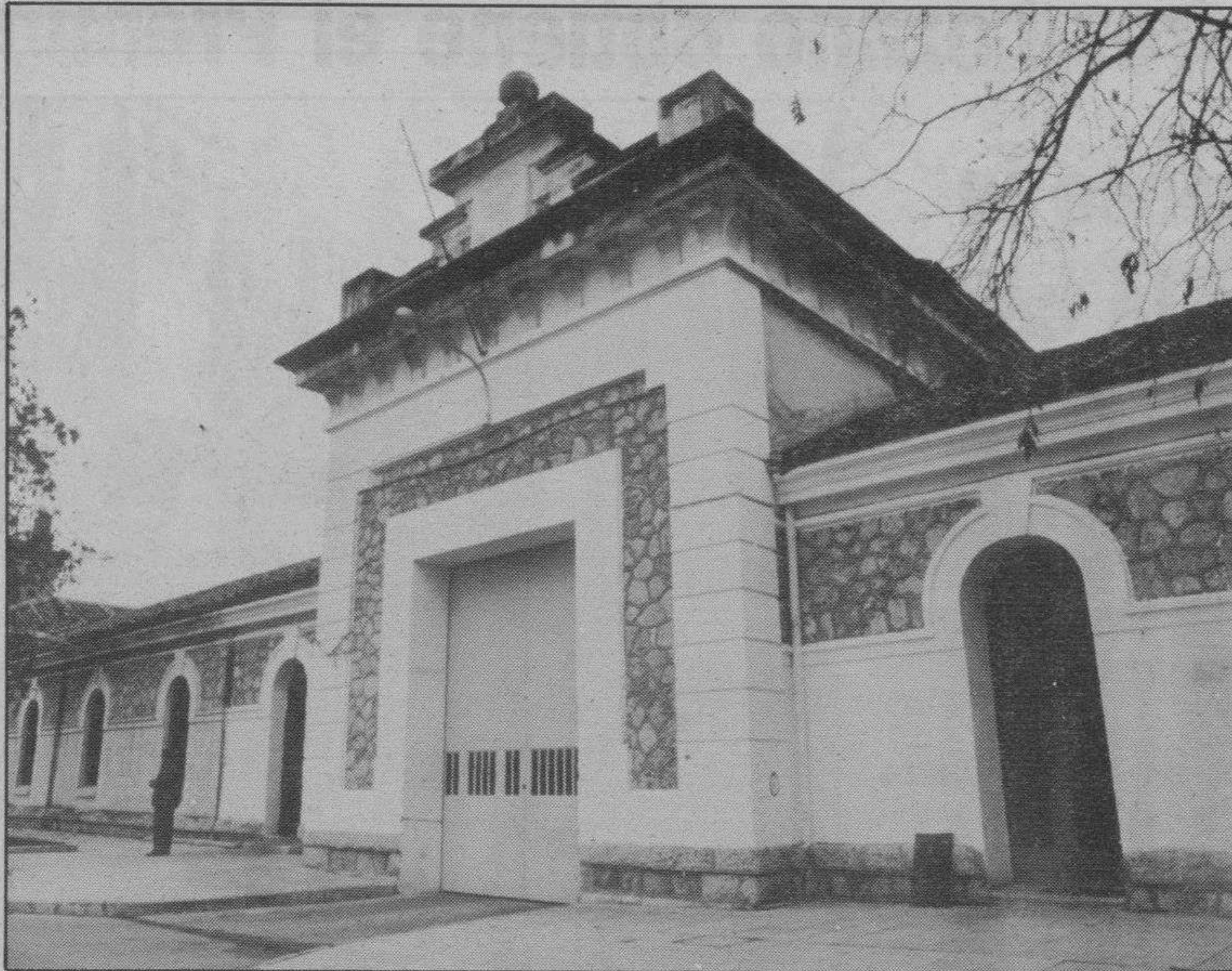
Instituciones Penitenciarias asegura que, debido a las obras, se redujo el número de internos, y nadie dijo nada en aquel momento. (Foto: DB)
