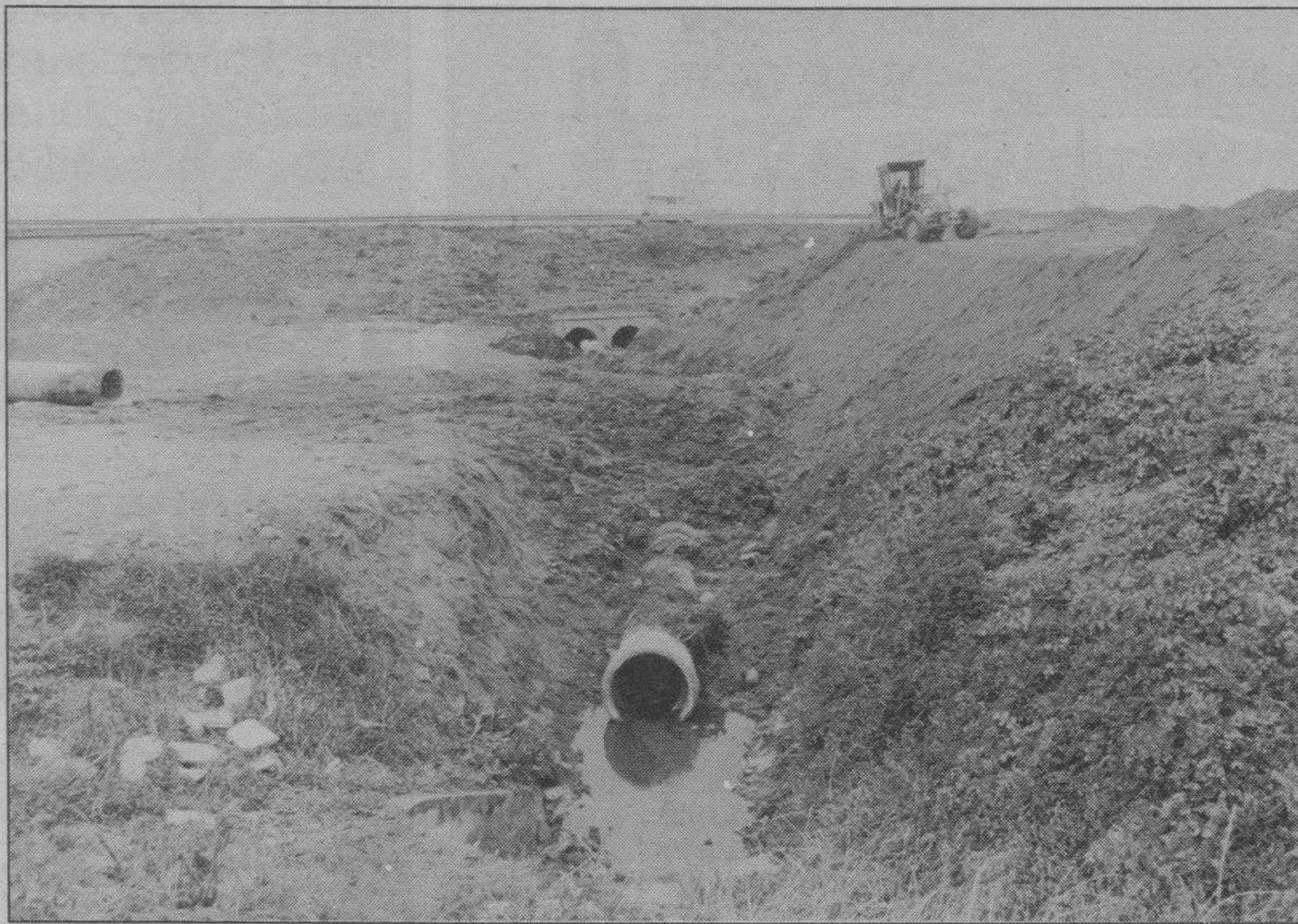
Penetración de cortes en una autovía. (Foto: DB).
