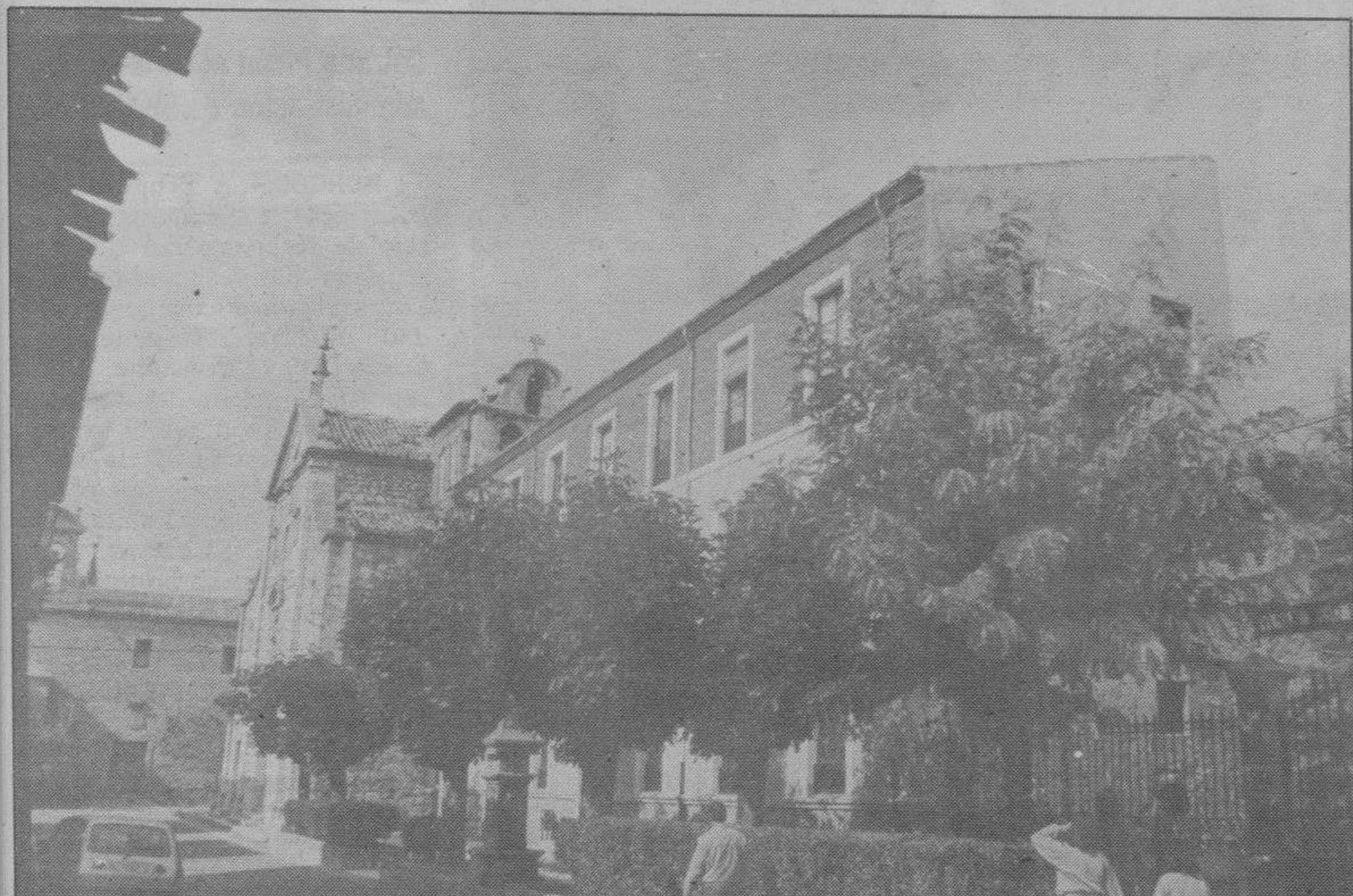
Las obras en la Casa Consistorial de Lerma costarán 6,5 millones.
