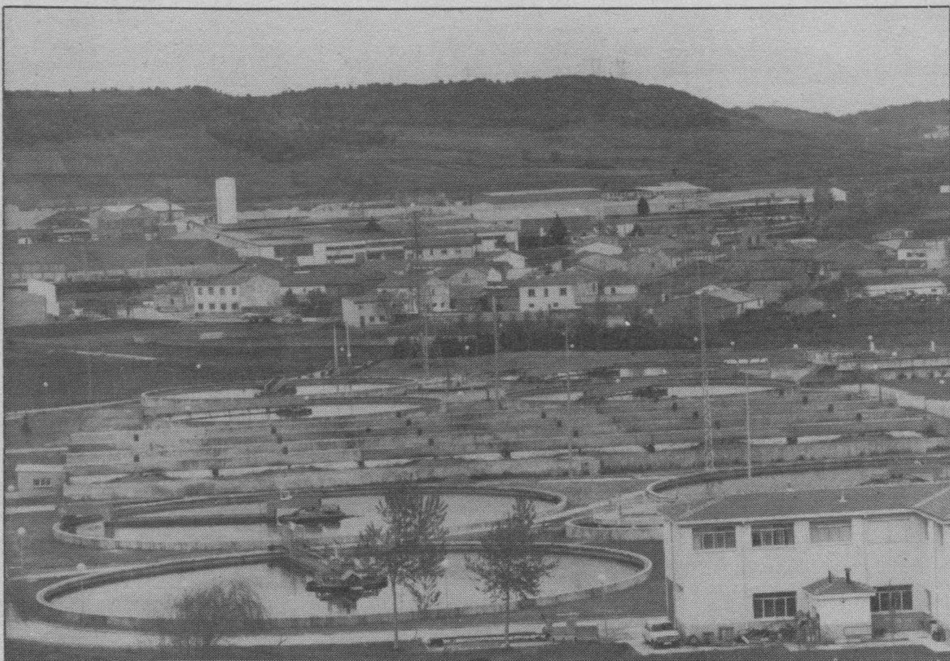
La planta, ubicada en Villalonquéjar, lleva en funcionamiento desde 1984. (Foto: J. Matías).
