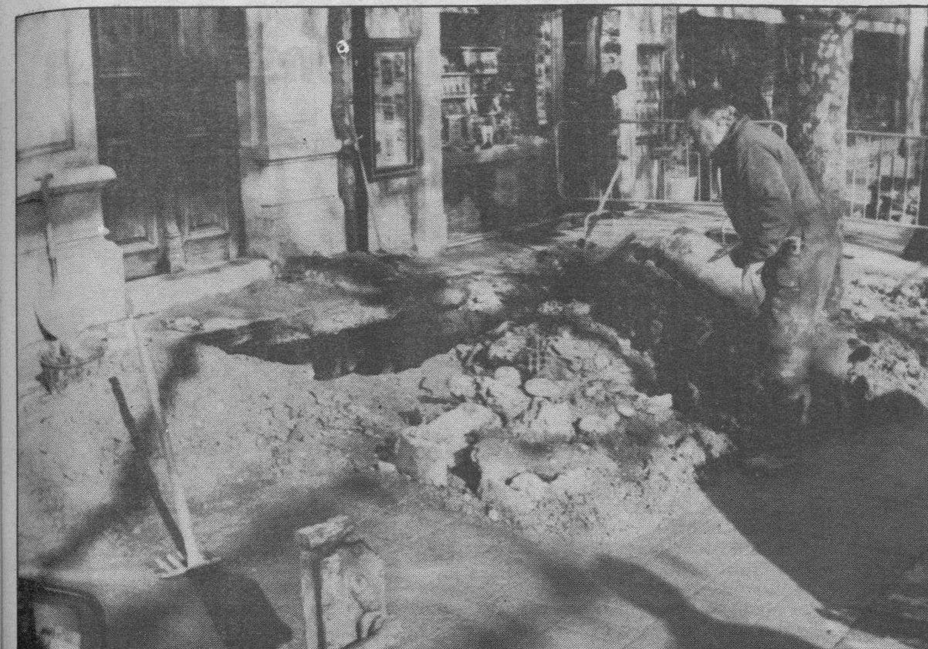
La Compañía de Aguas procedió a la localización y reparación de la avería. (Foto: L. L. Araico).
