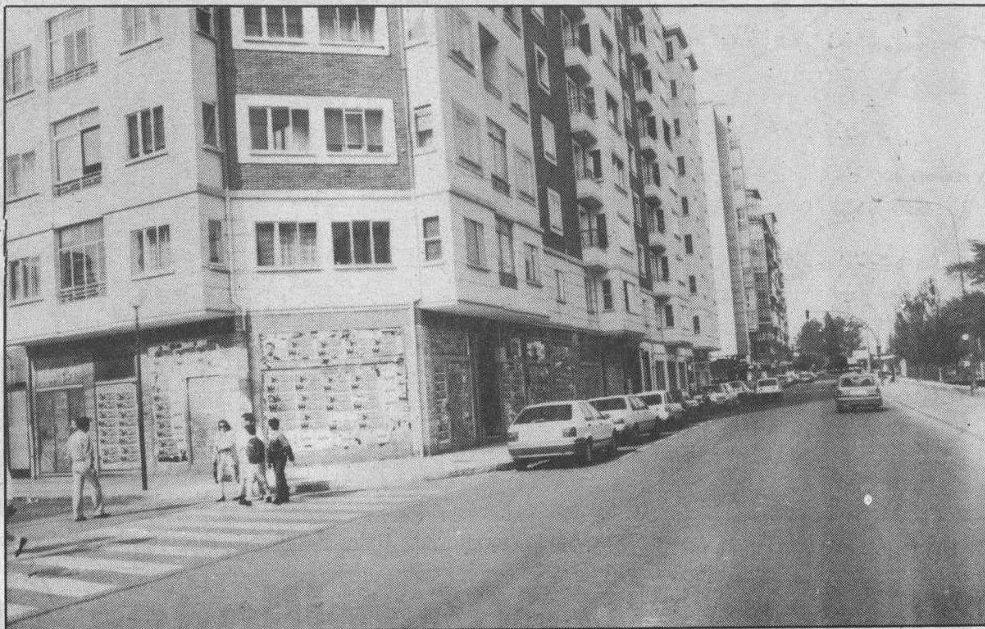
Los minicines se construirán en los bajos del número 37 de General Sanjurjo.(Foto: J. Matías).
