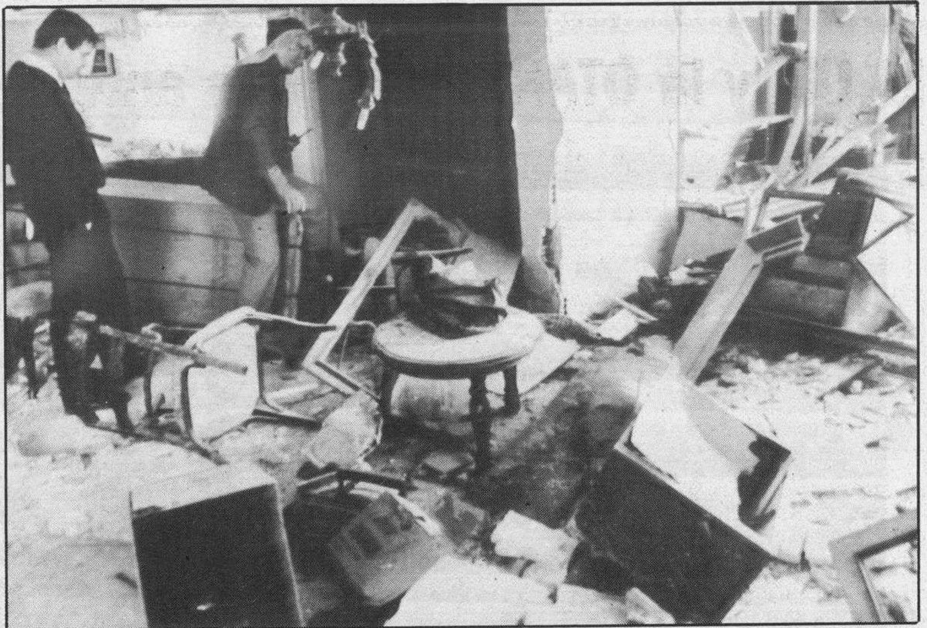
Una mujer herida muy grave y 20 viviendas desalojadas por una explosión de gas. (Foto: Efe).
