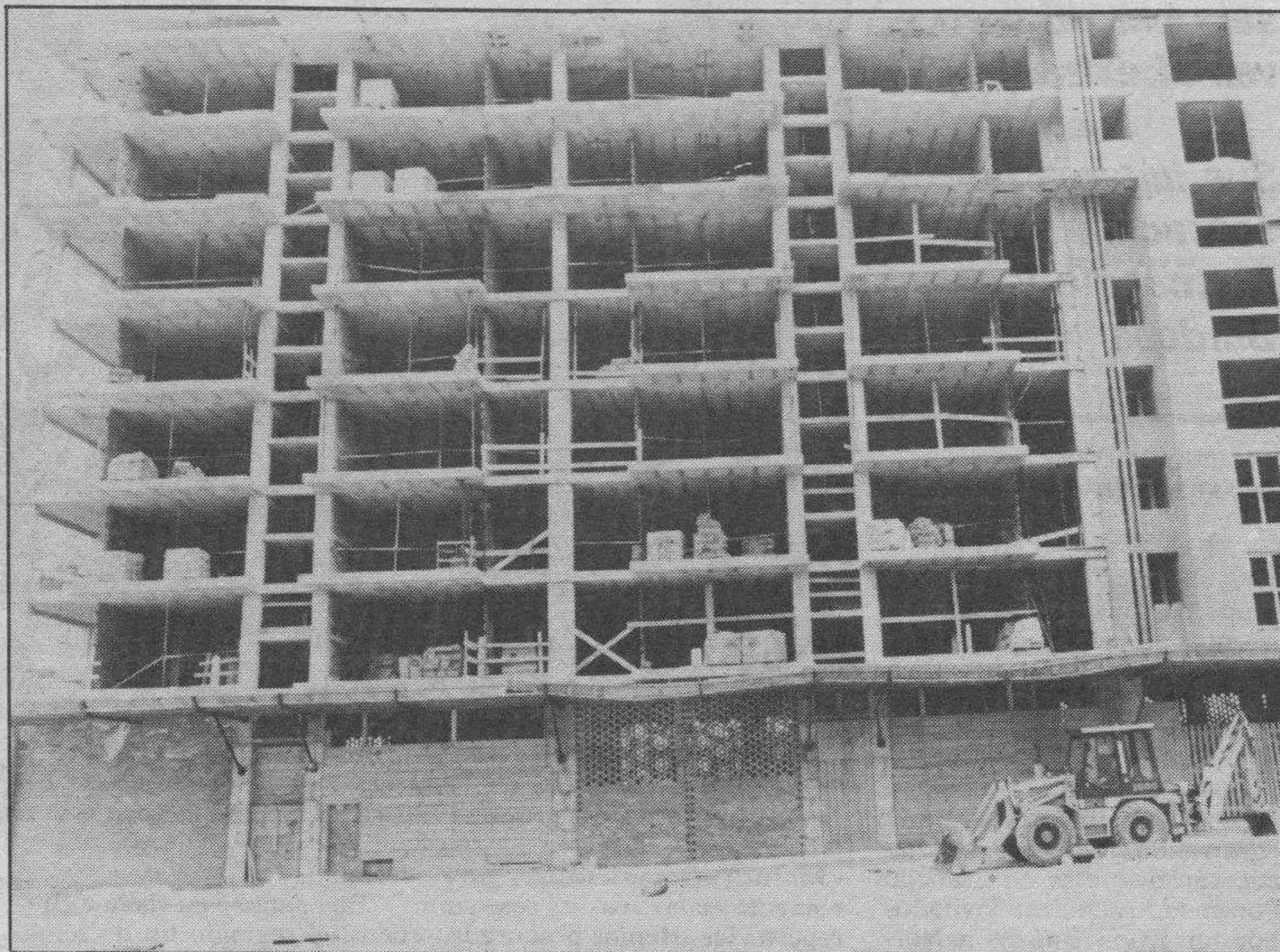
Las obras siguen provocando declaraciones de los implicados. (Foto: Truchuelo)
