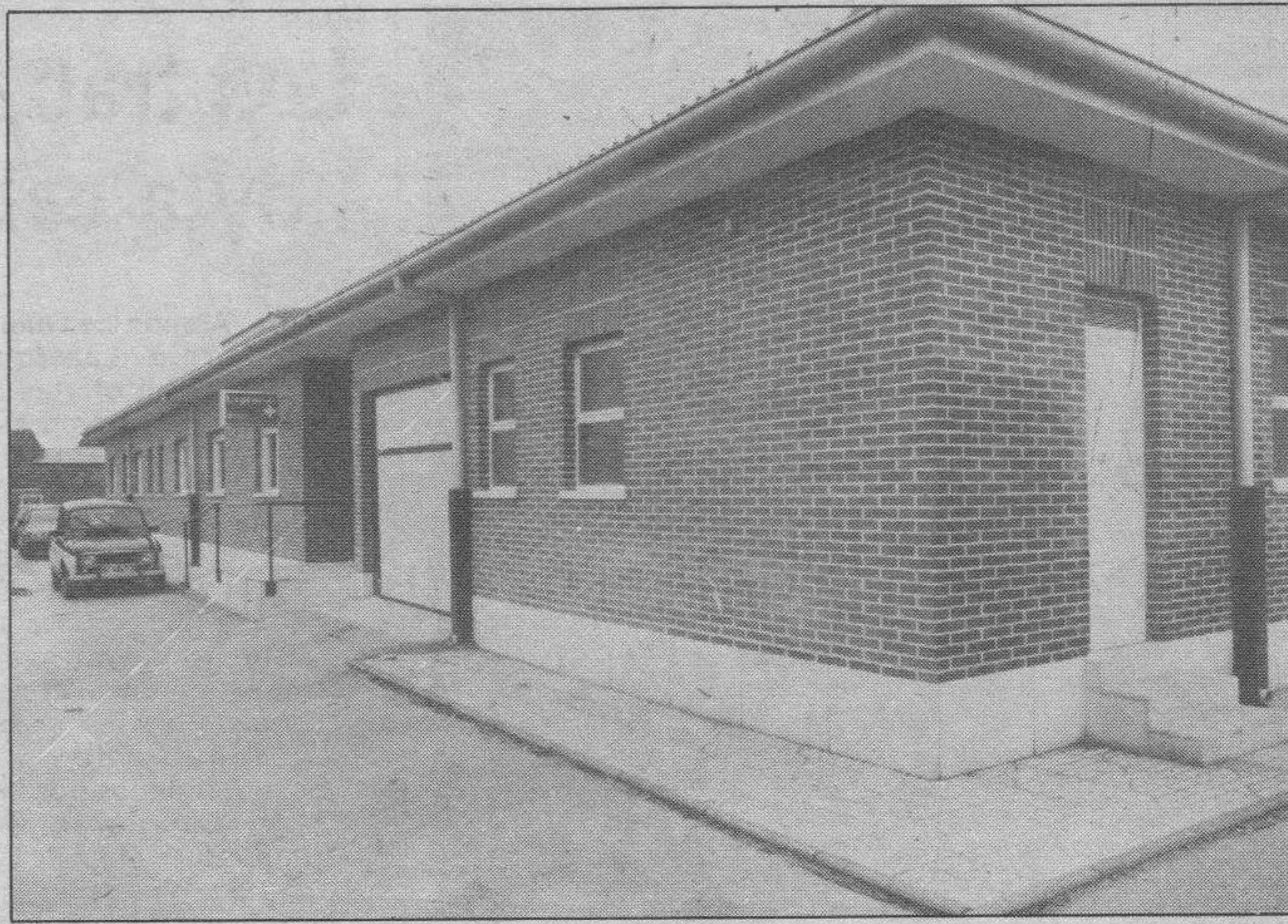
El centro de salud de Pampliega tiene una superficie de 459 metros cuadrados y en su construcción se invirtieron 36 millones de pesetas (Foto L. Matías)
