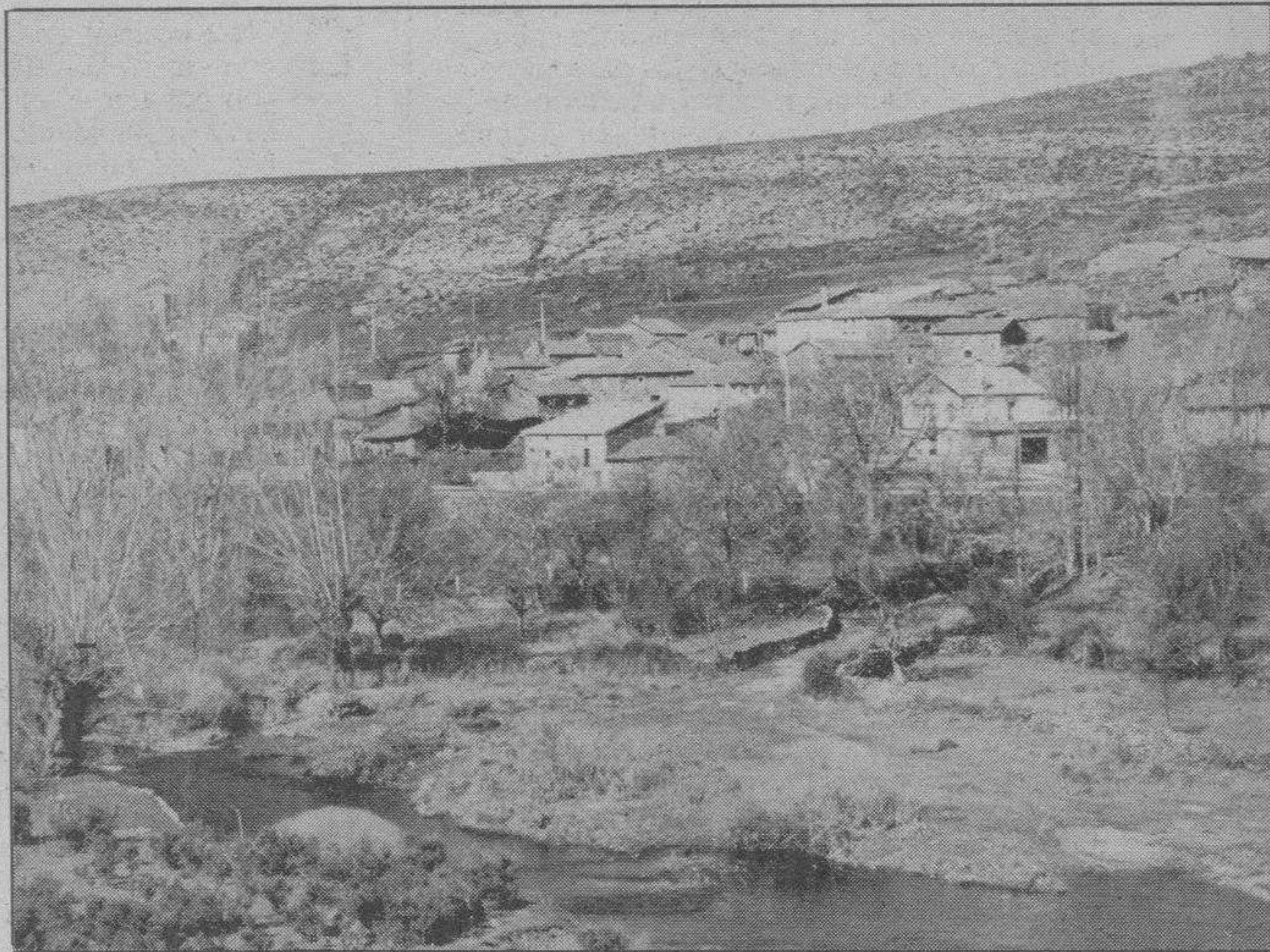
Terrazas, hoy barrio de Salas, quedará anegado por las aguas del embalse. Foto L. Matías
