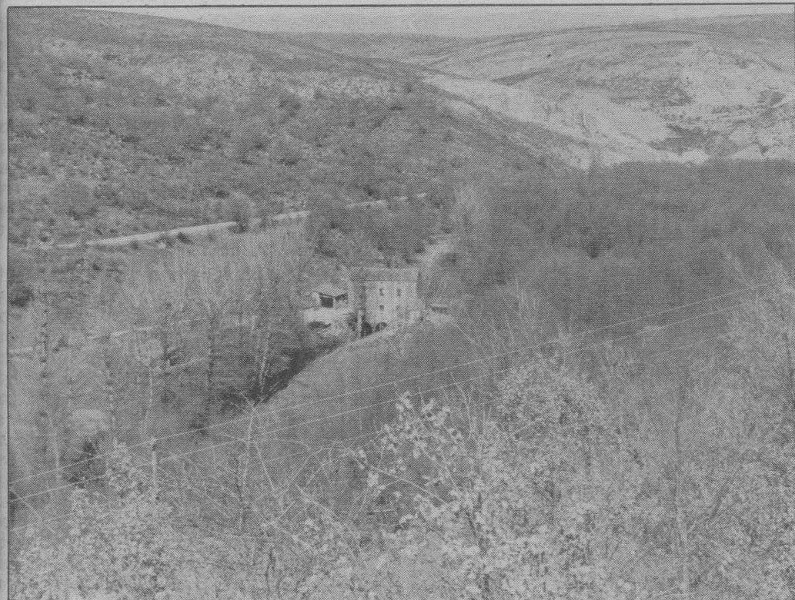
La futura presa de Castrovido se sitúa a unos 300 metros del puente. Fotos L. Matías
