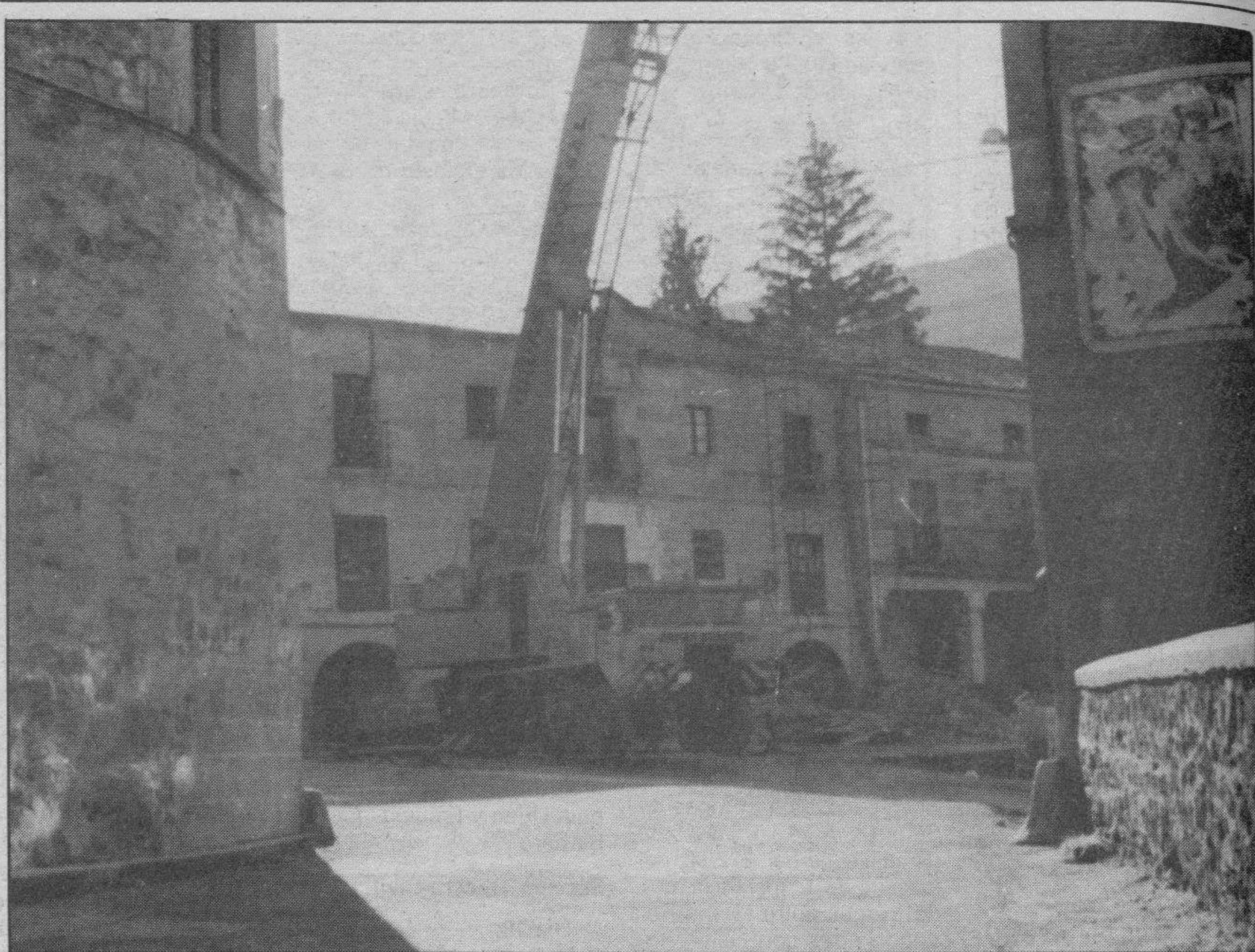
Ayuntamiento de Sedano en obras
