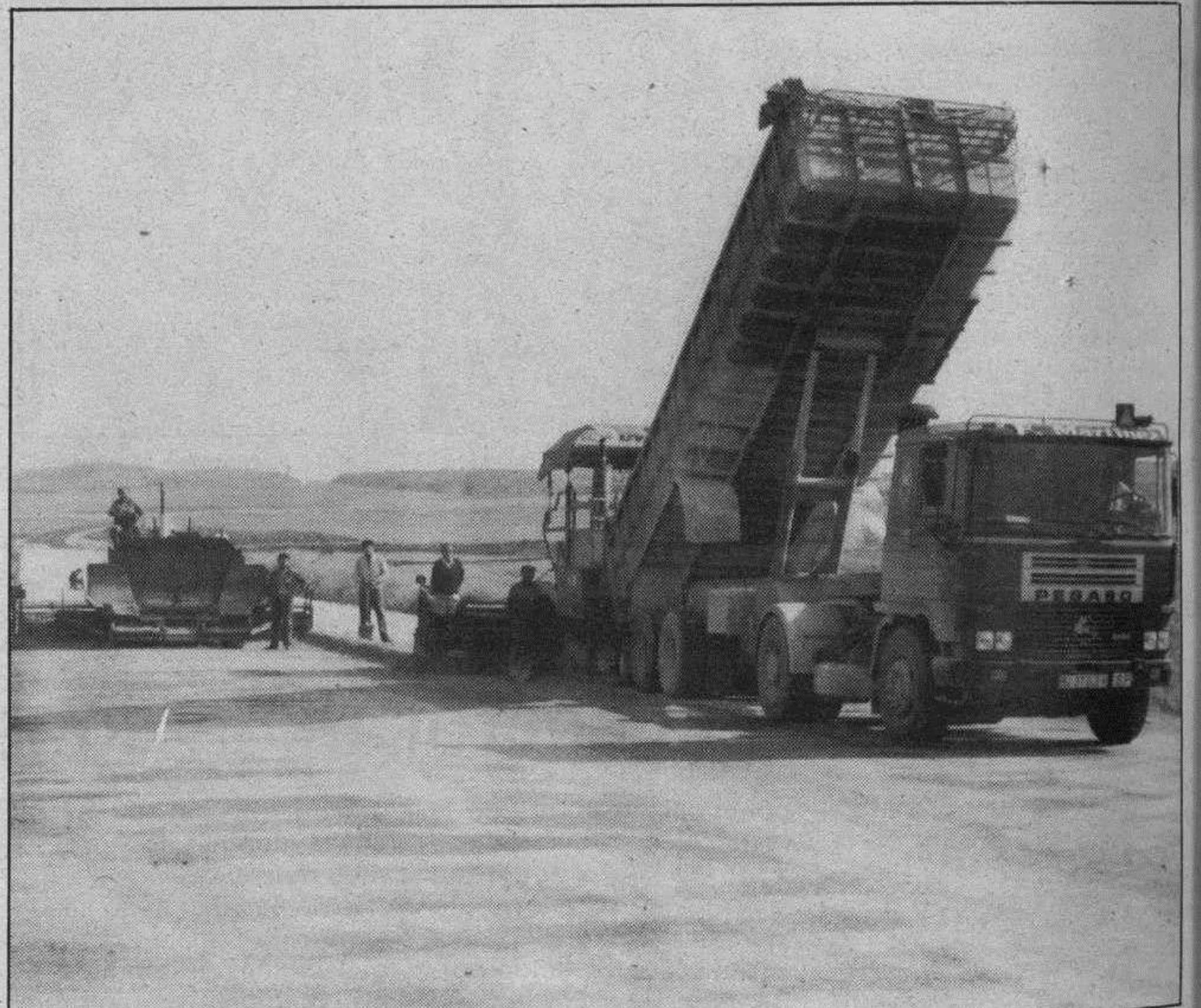
Ultimos camiones de grava-cemento en el tramo Montorio-Ubierna.
