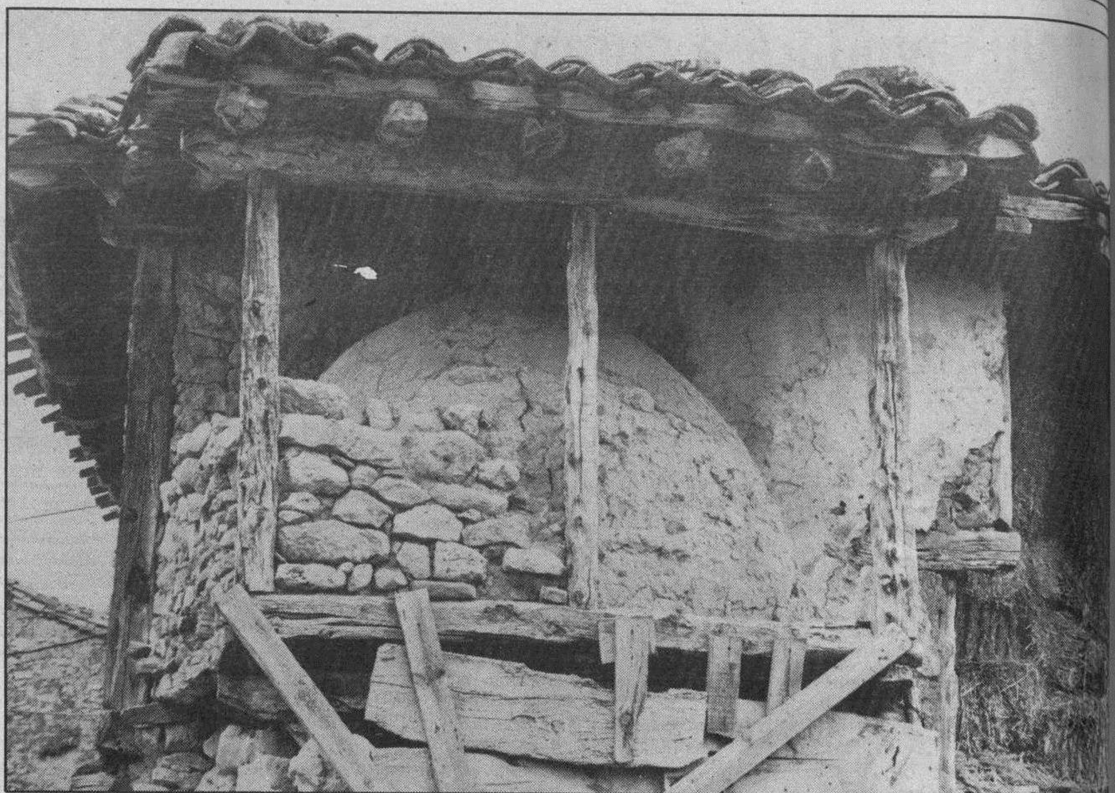
En Santo Domingo de Silos todavía es posible encontrar viejos hornos de barro y pilares de enebro. (Foto A. Ayala)
