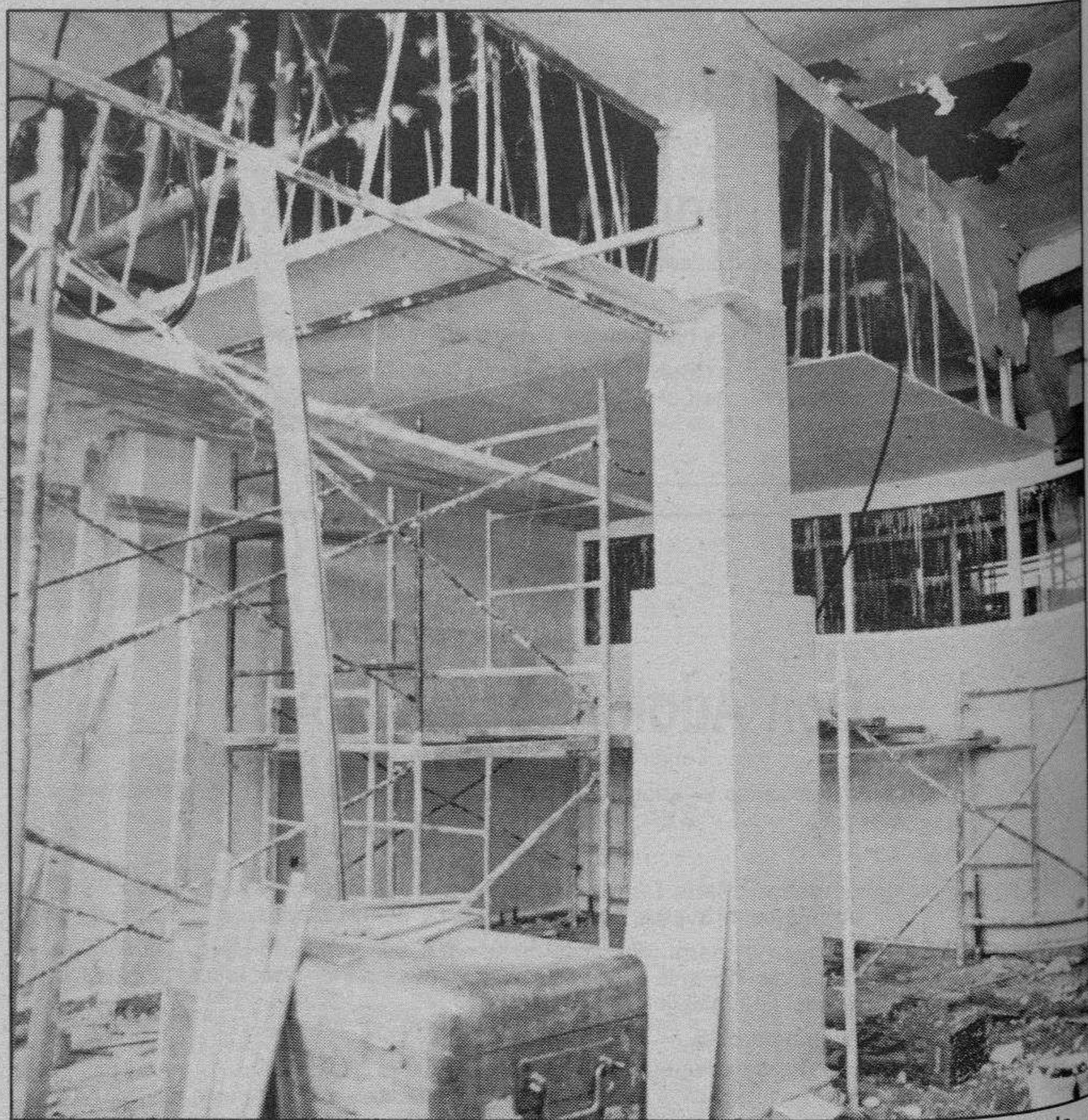
Aspecto parcial de las obras, que el viernes estarán prácticamente finalizadas. Foto A. Ayala
