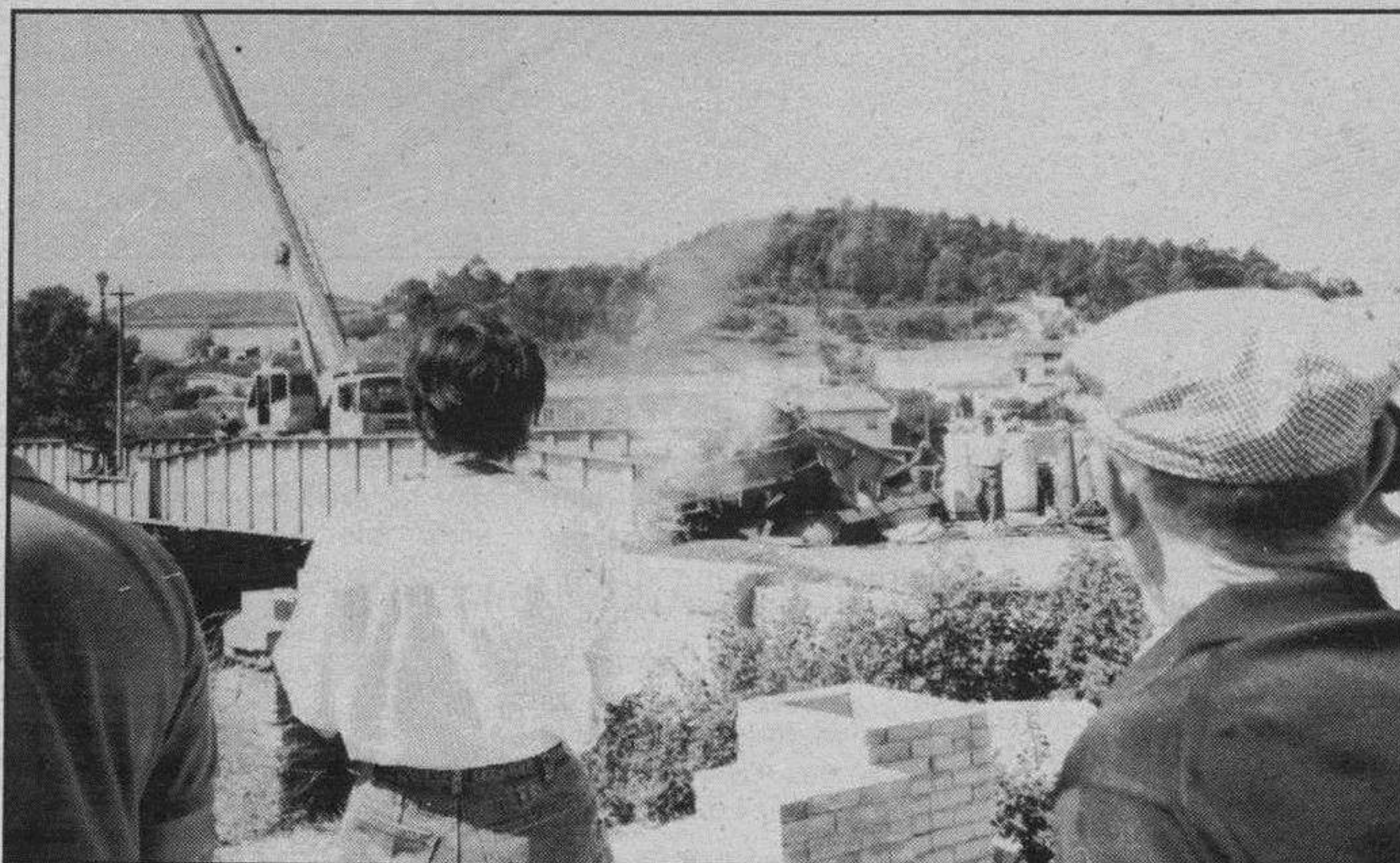
El Puente de Hierro al desguace. — Comenzó el desguace del Puente de Hierro, cuando pensábamos que la segunda fase del proyecto Ronda de Ferrocarril-Fuentecaliente se dejaría para más adelante, de lo cual nos alegramos. Foto Truchuelo.
