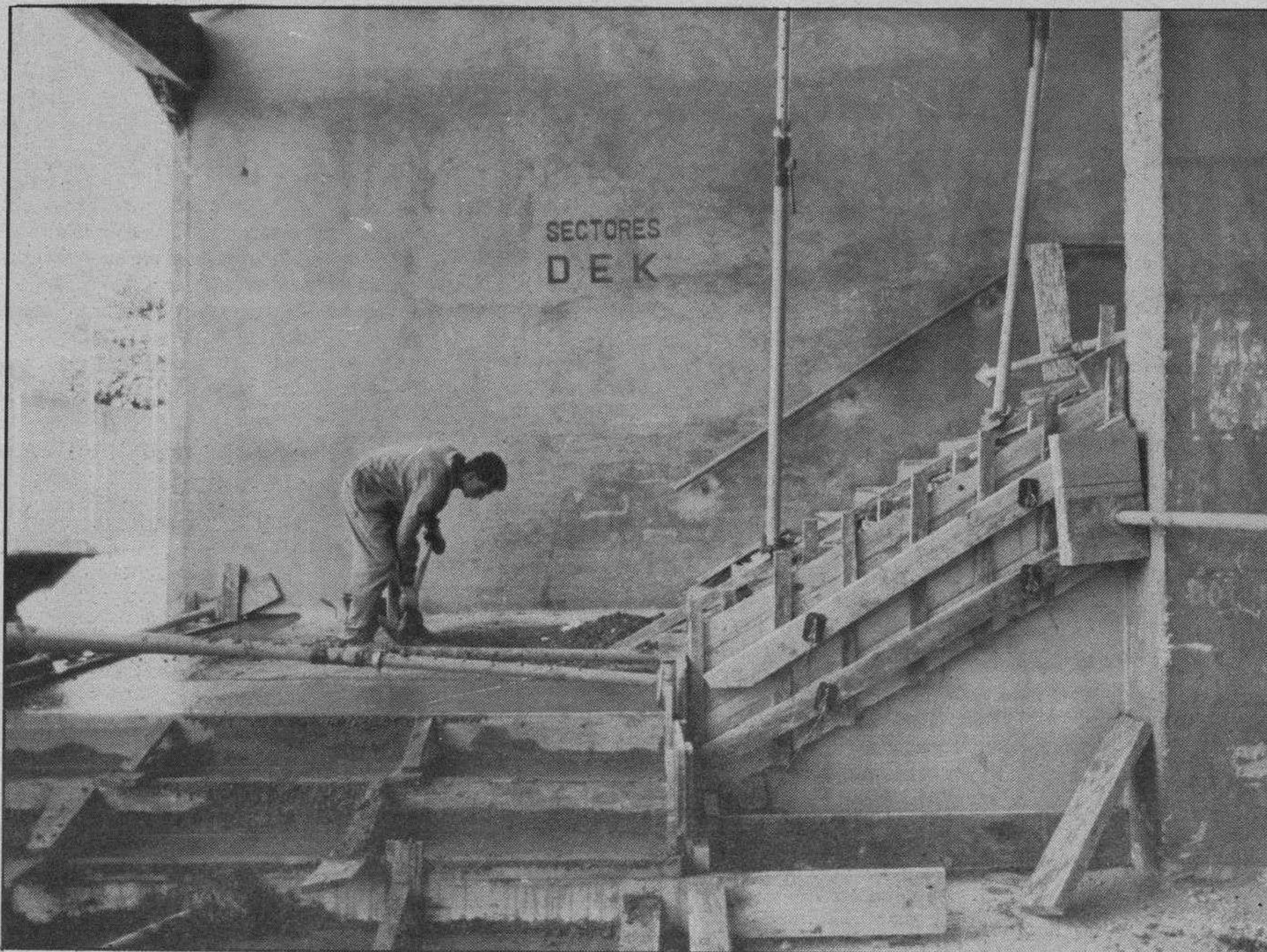
Se están ampliando las escaleras que conducen a las gradas. Foto J. Matias.
