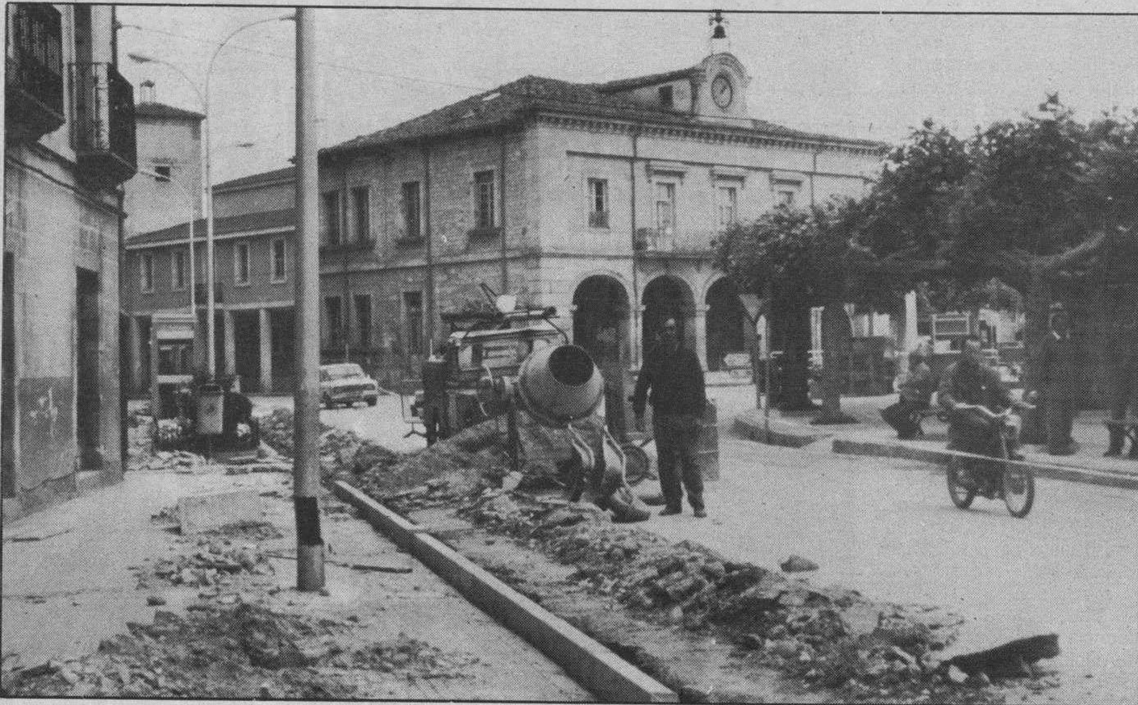
Aspecto de las obras que se están realizando
