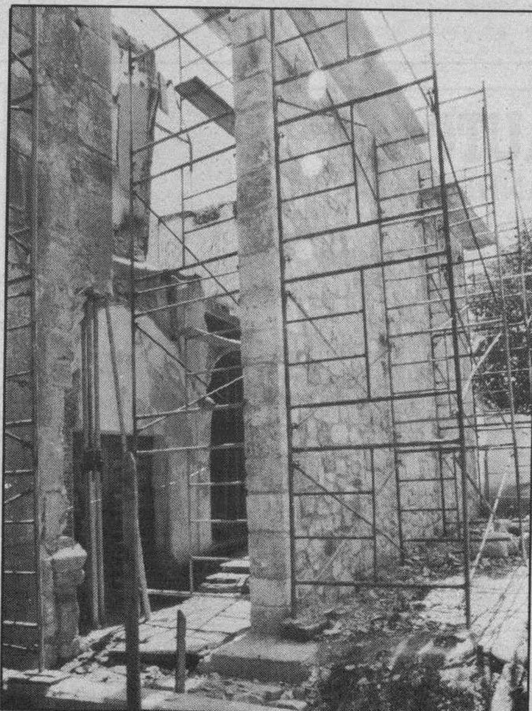
Muro reconstruido en su totalidad y perspectiva de distintas estancias a cielo descubierto. Foto J. Matías.
