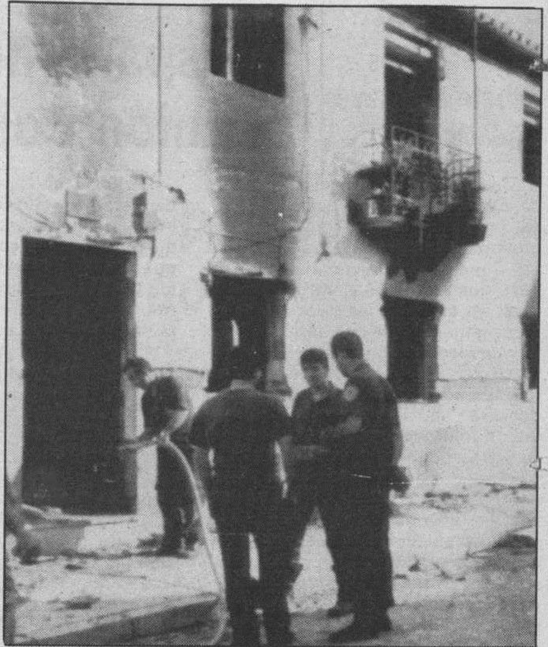
Fachada de la casa donde ocurrió la explosión de gas butano.
