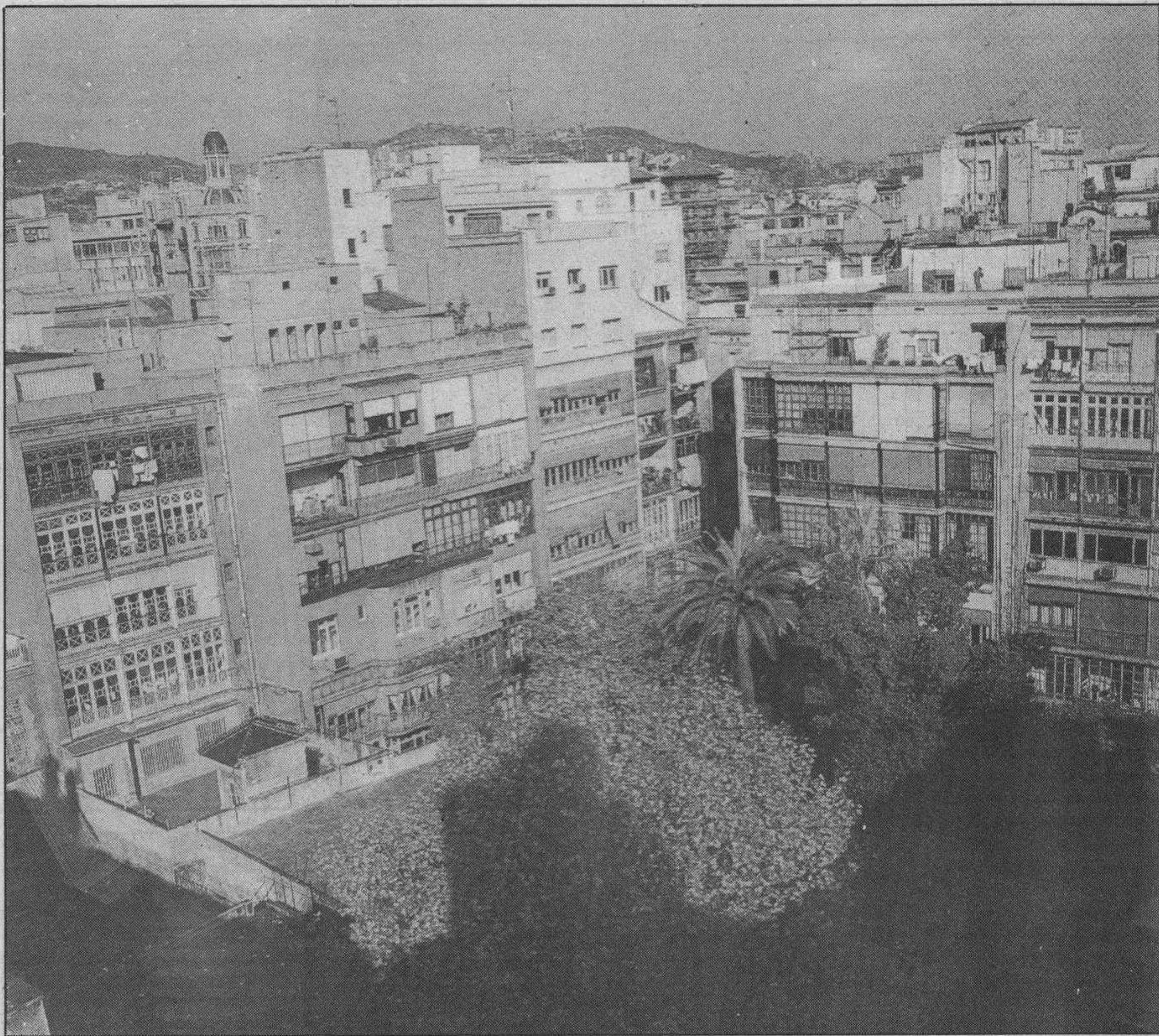
El MOPU concede ayudas para rehabilitar viviendas en colaboración con las Comunidades Autónomas.
