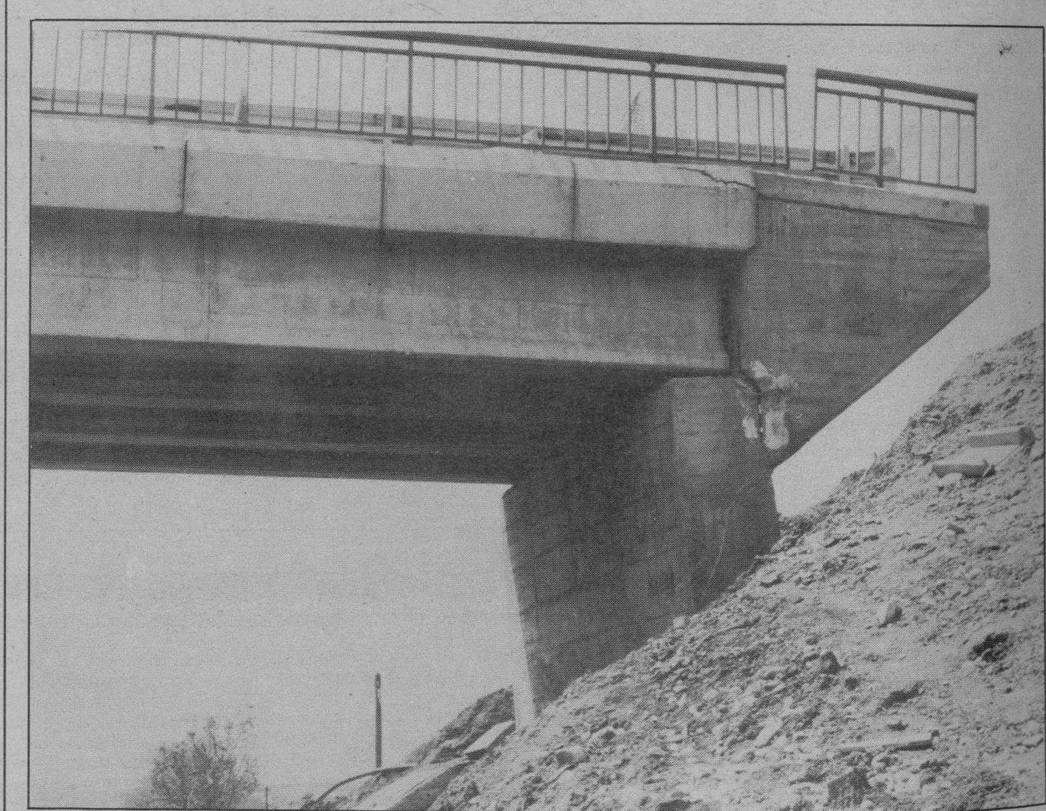
Reparación del puente. — Uno de los puentes para paso agrario de la autovía Madrid-Burgos está siendo reparado. Parece que una de las columnas de sostenimiento se ha removido y los servicios correspondientes están consolidando el paso. Muy pronto ha ocurrido esto, cuando todavía no está toda la autovía en servicio.
