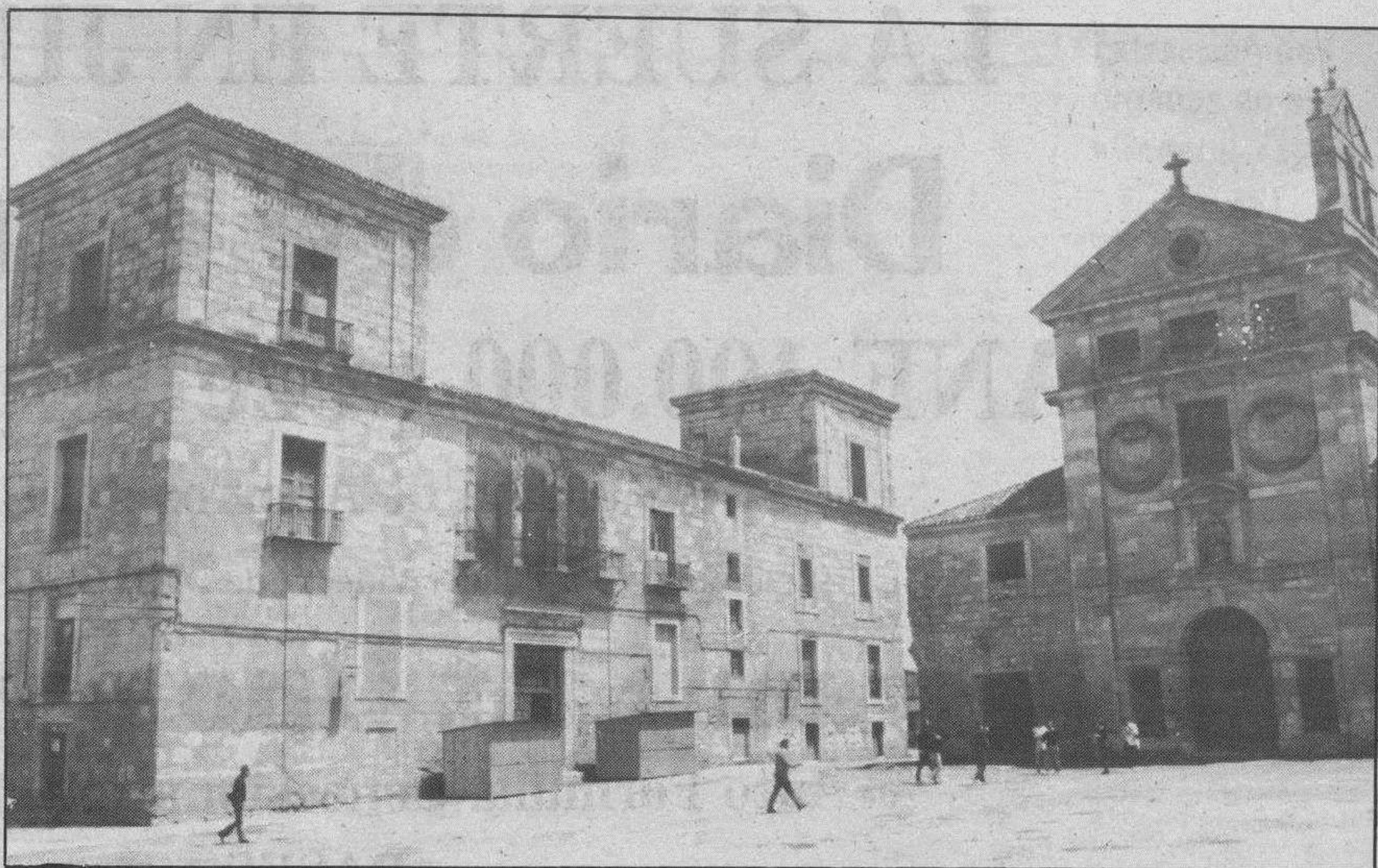
Patrimonio dio «luz verde» al estudio previo a la rehabilitación del Palacio Ducal de Lerma para hotel. (Foto Archivo).
