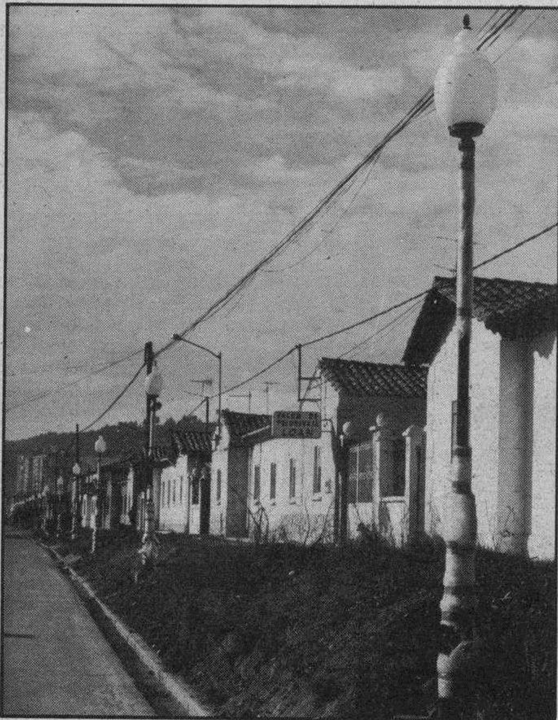
Nuevas farolas. — Cuarenta y cuatro nuevas farolas se han colocado en las Barriada de Yllera, concretamente las de la fotografía corresponden a la calle Condessa Mencía. Esto mejorará el espacio urbano y el alumbrado, pero es necesario suprimir tanto cable aéreo como se presenta en este lugar.
