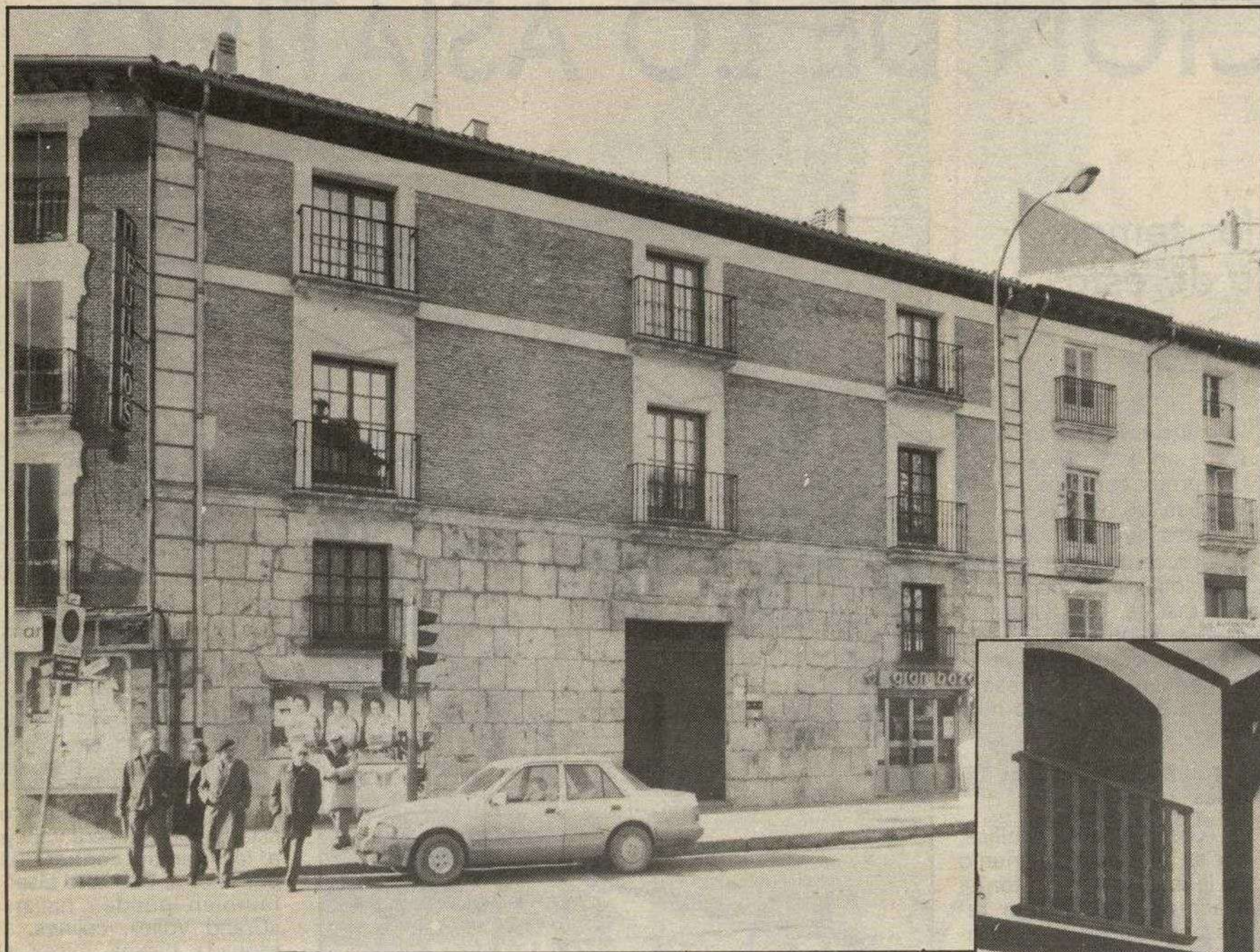
Fachada del edificio Real Consulado, en el número 9 de la Plaza de Vega
