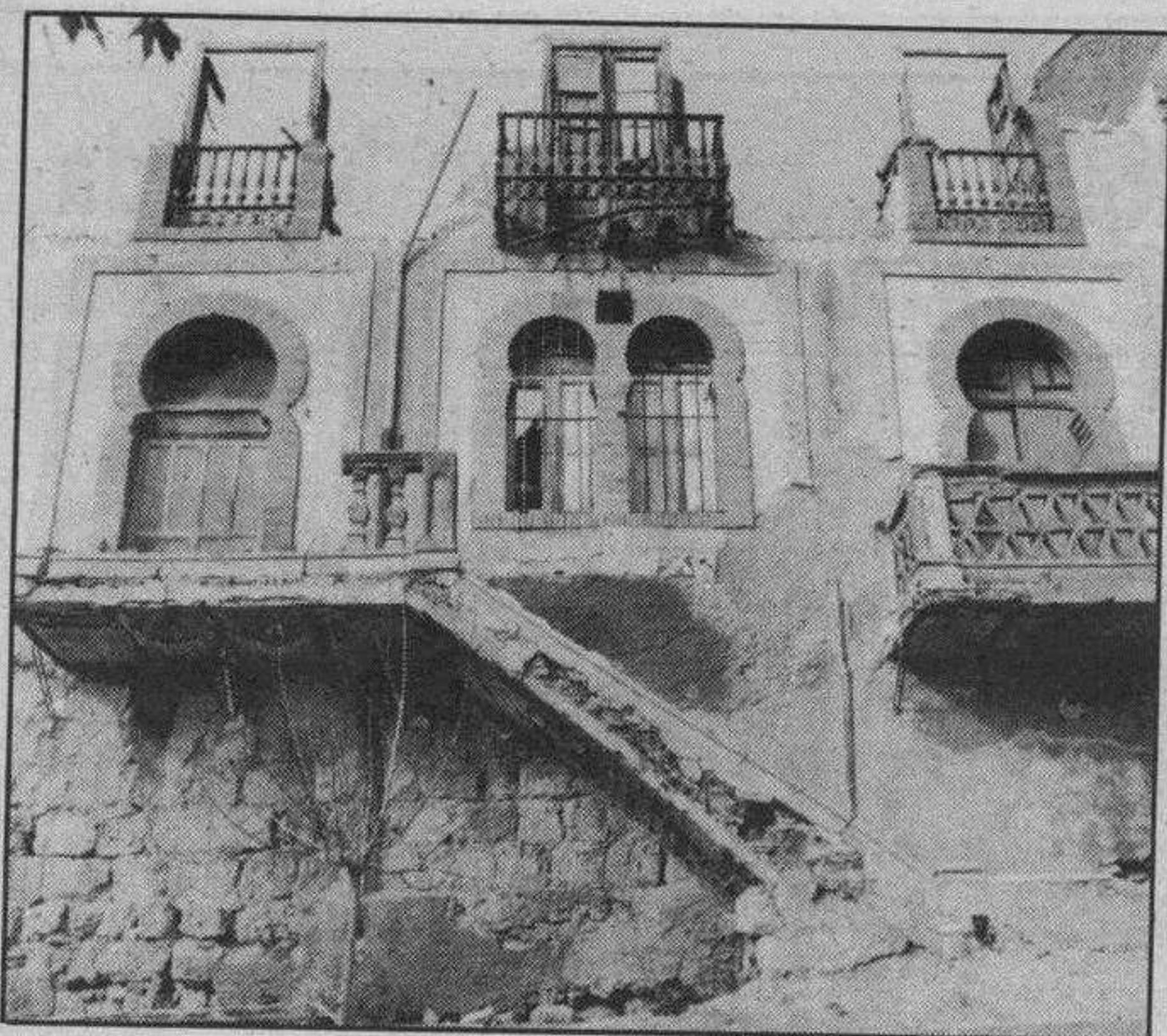
Pronto terminarán las obras de derribo de esta casa en Roa. Foto Lara.
