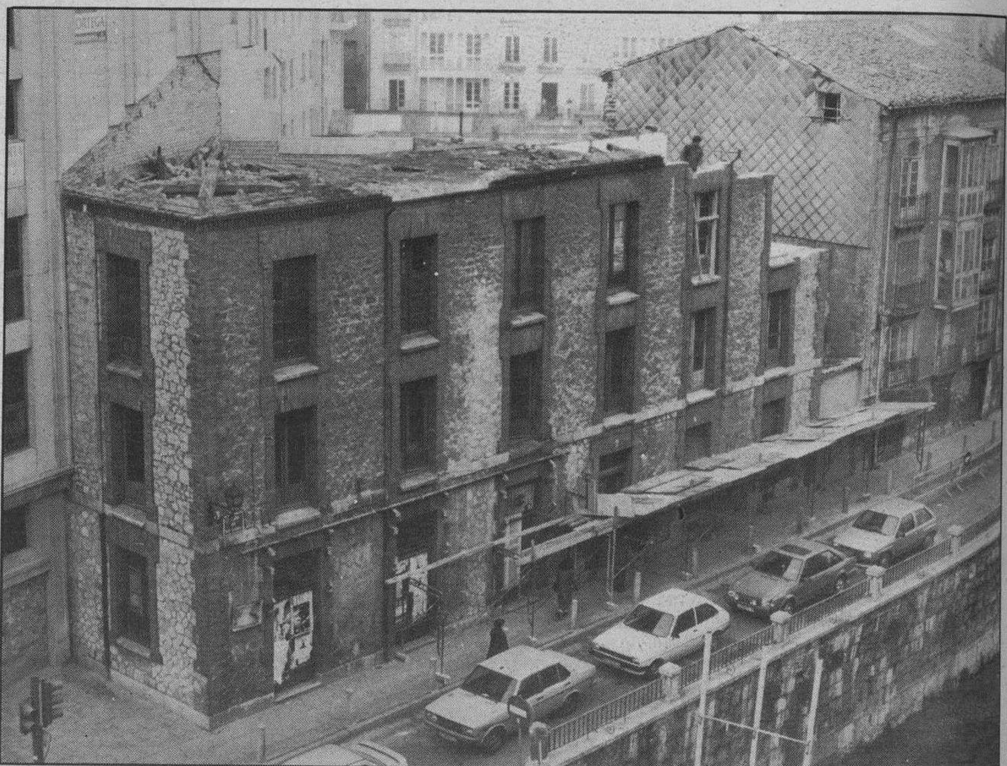
Obras de «Casa Garilleti». — Estas son las obras de «Casa Garilleti» que están en marcha en una zona de San Lesmes, junto a la muralla de la ciudad. Esta imagen se modificará con los trabajos de construcción del nuevo edificio, de acuerdo con los trámites que días pasados anunciaba el arquitecto Pedro del Barrio Riaño. «Garilleti» fue un establecimiento entrañable con gran historia en la hostelería burgalesa, que hace unos años dijo adiós a su actividad. Ahora lo hace la fisonomía de este rincón de la ciudad.
