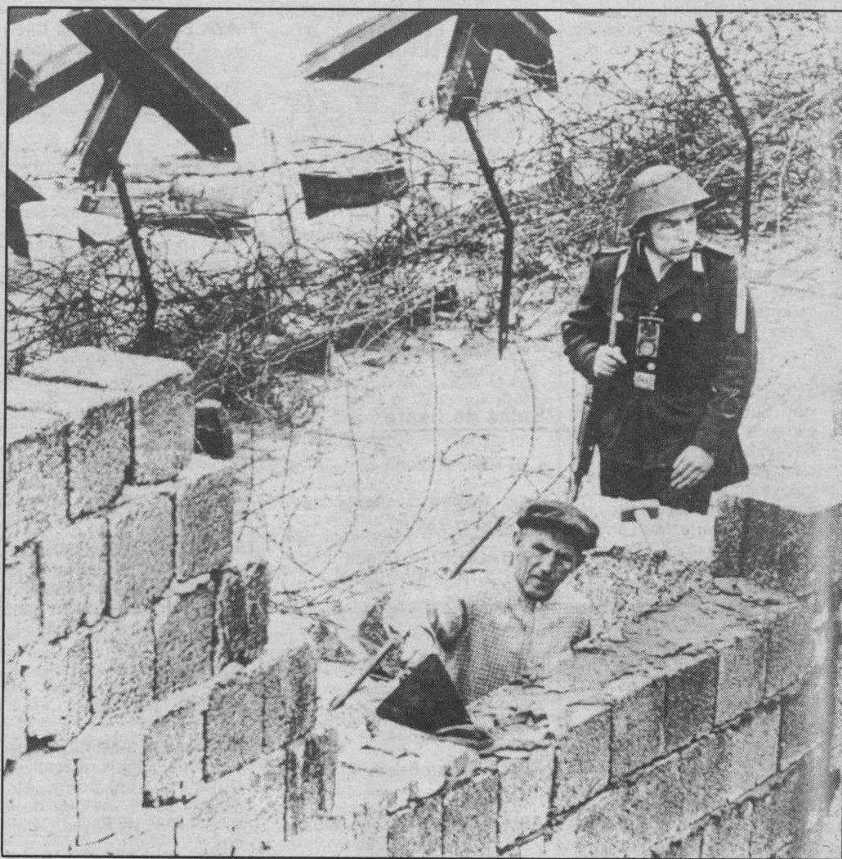
Construcción del muro en una de las calles de Berlín.
