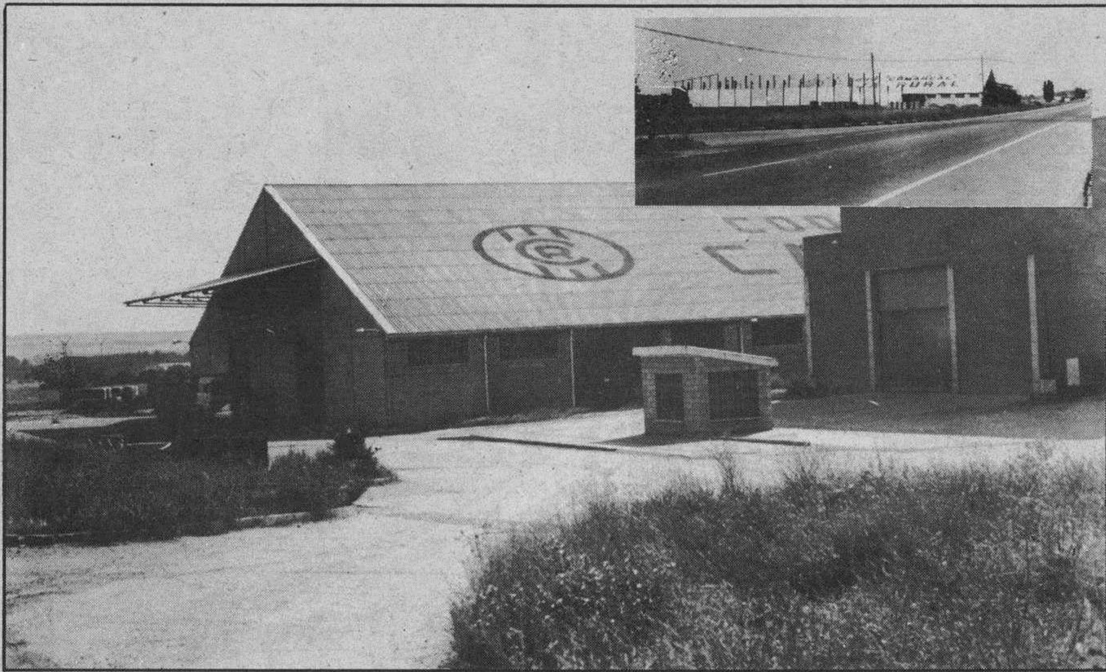
Instalaciones de la cooperativa «Arlanza», en Lerma. Foto Luis.
