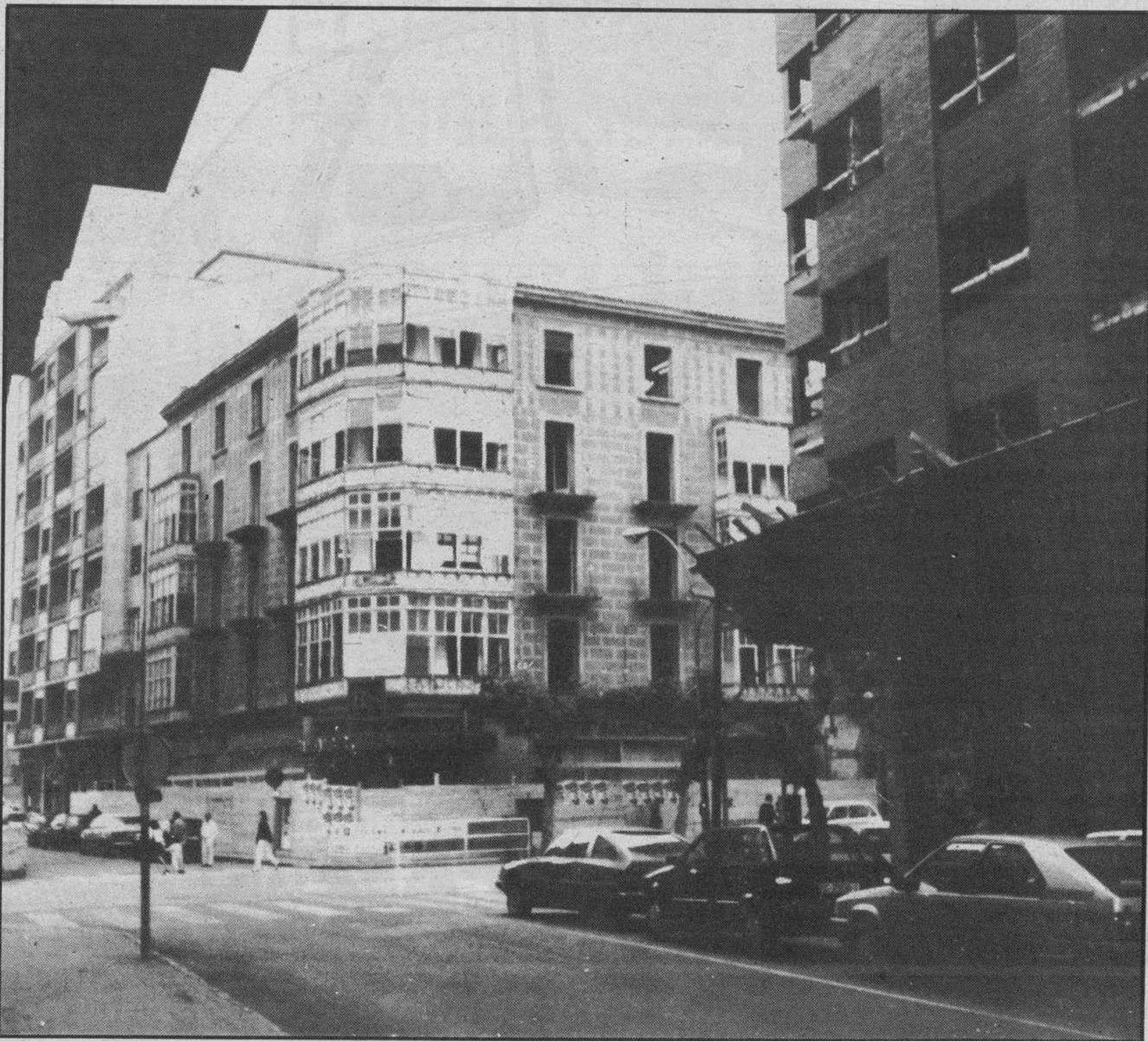
Adiós a un hermoso edificio.— Como se puede apreciar en la fotografía, el edificio que vemos al fondo de la misma, ha entrado en el capítulo de derribos. Derribos que en unas ocasiones tienen mayor o menor justificación, pero que se llevan a efecto, cambian la fisonomía urbana y «arrancan» pedazos de nuestra historia. Tendrá que ser así. Estamos hablando de la casa que ocupa —casi ocupaba— la esquina de las calles Estación y Dos de Mayo, en cuyos bajos estuvo el Casino de Miranda, después un comercio de tejidos y finalmente el Banco de Santander. R.I.P. Foto Truchuelo.
