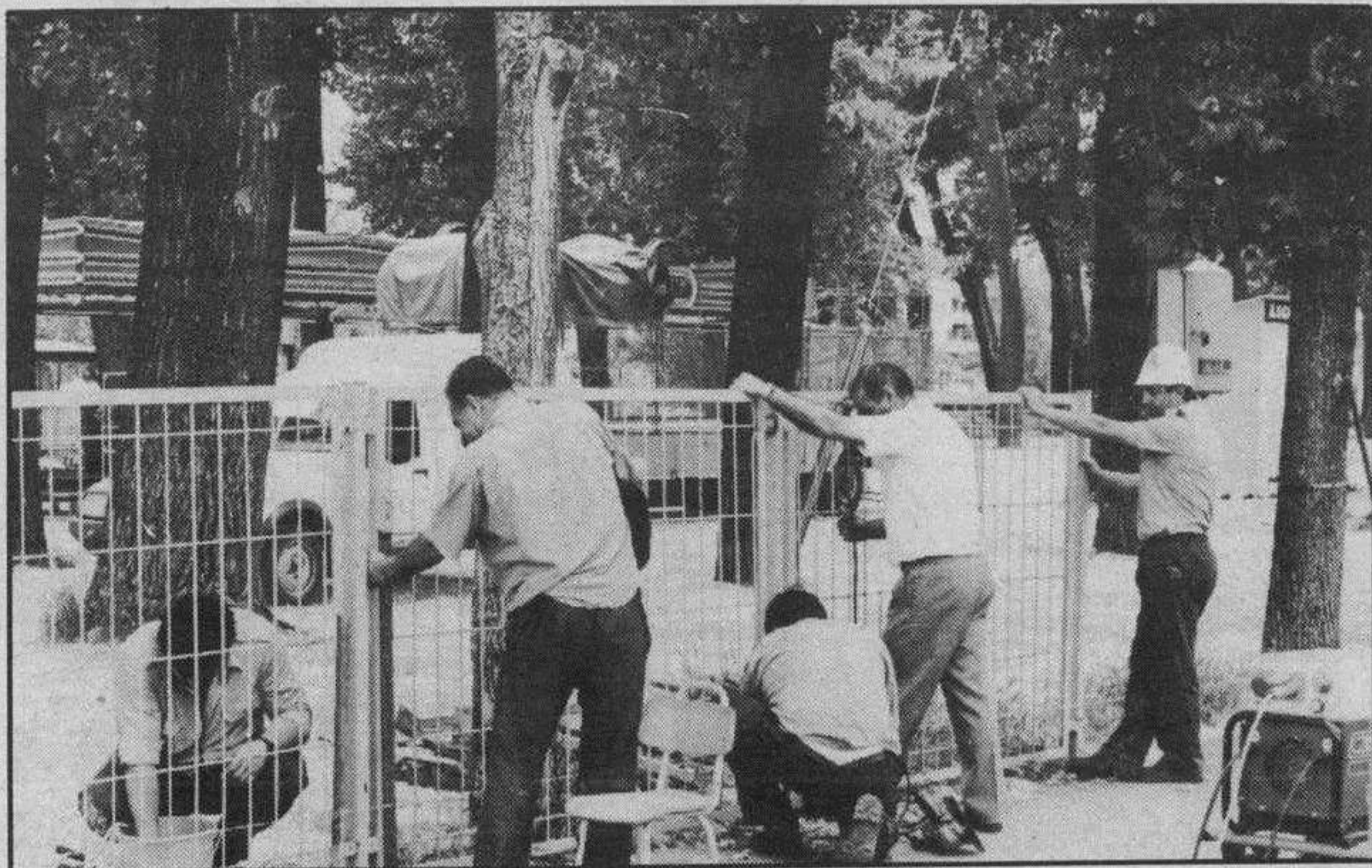
Algunos operarios realizan el montaje de las vallas de protección en el recinto
